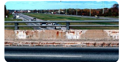
d) Разрушение бетона и «раскрытие» арматуры
