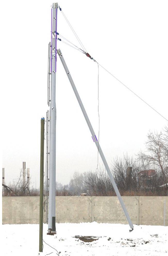
Деформация опоры с подкосом ( F=28 кН)
