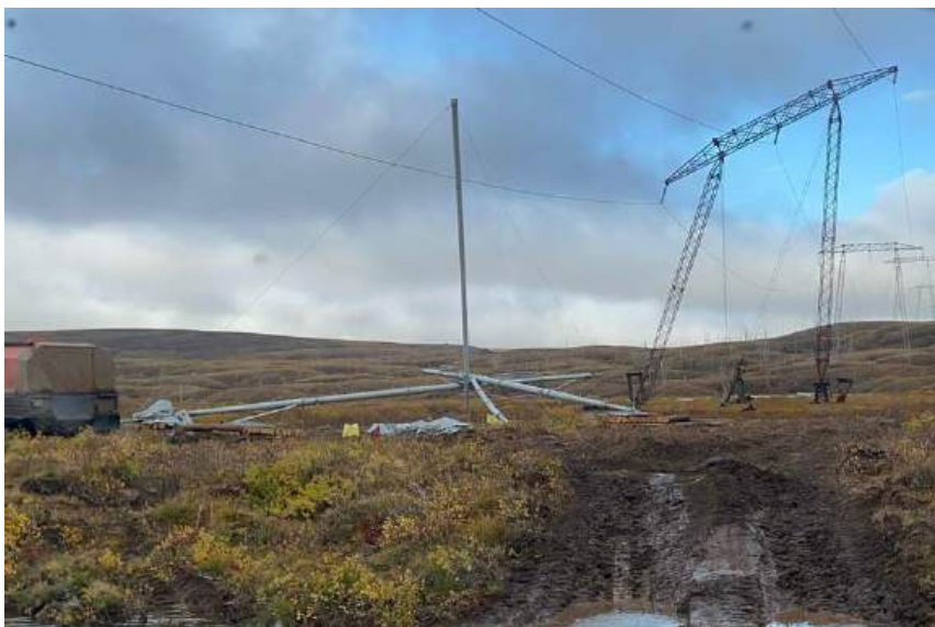
Начало самоподъема опоры в рабочее положение
