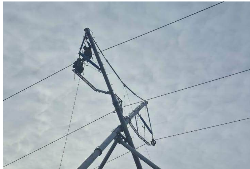
Работа с боковым проводом на раскладных площадках
