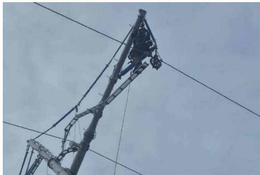
Перекладка провода с раскатного ролика в зажим
