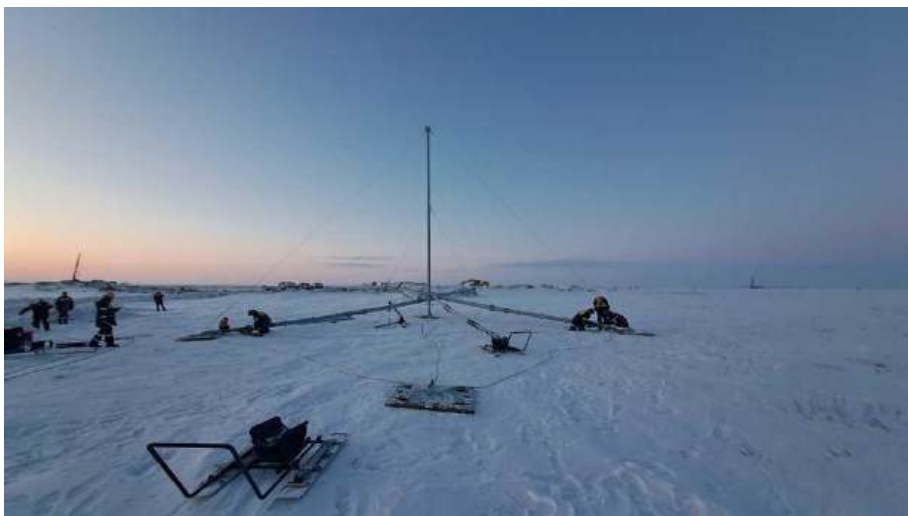
Ручные приспособления для сборки и возведения опоры
