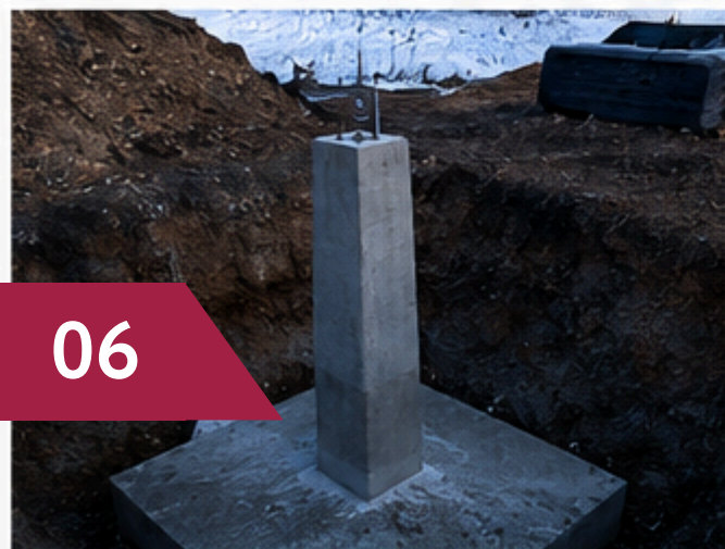
Железобетонные фундаменты опор
