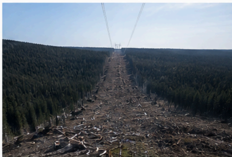
Участок строительства ВЛ 500 кВ
