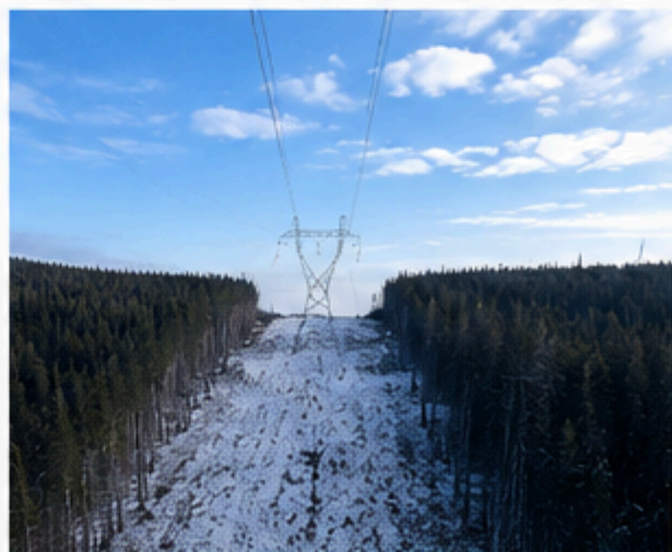
Общий вид трассы ВЛ 500 кВ
