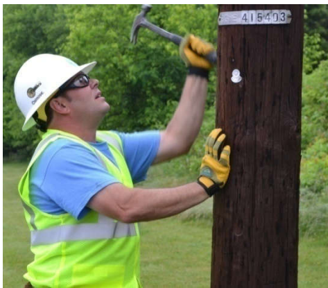
Простукивание (дер. Опоры)
