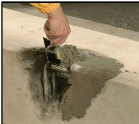
Обработка ЖБ конструкции специальными ремонтными цементными составами.
