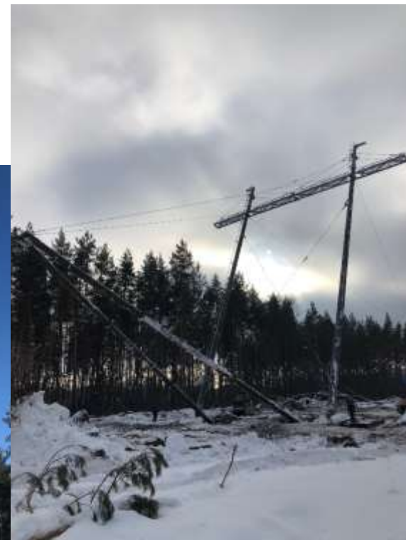
Подъем опоры методом падающей стрелы
