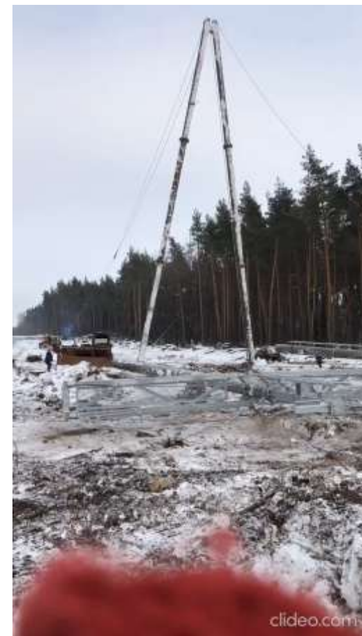
Подъем опоры 2СПБ500-3В «падающей стрелой», 2019
