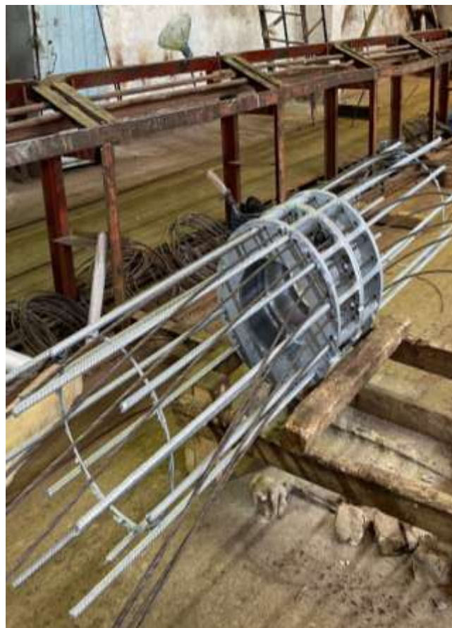
Протяжка напрягаемой арматуры сквозь закладную деталь
