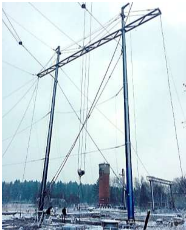
Испытания опоры 2СПБ500-3В на полигоне ОРГРЭС, май 2015
