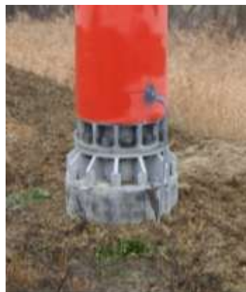
Узел соединения стойки с фундаментом
