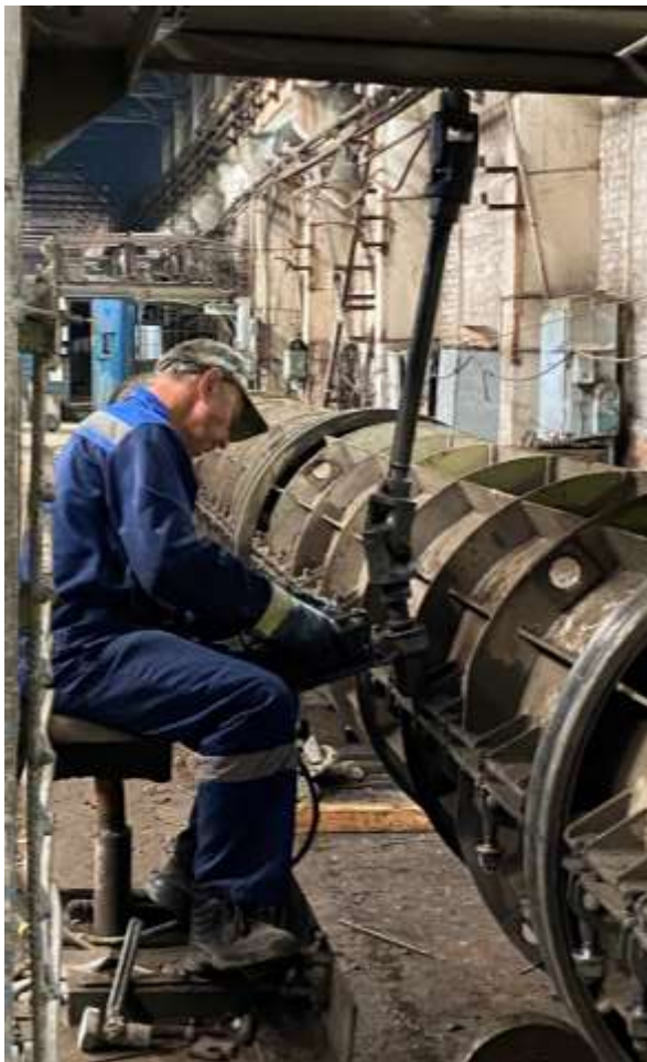
Фиксация верхней и нижней частей опалубки
