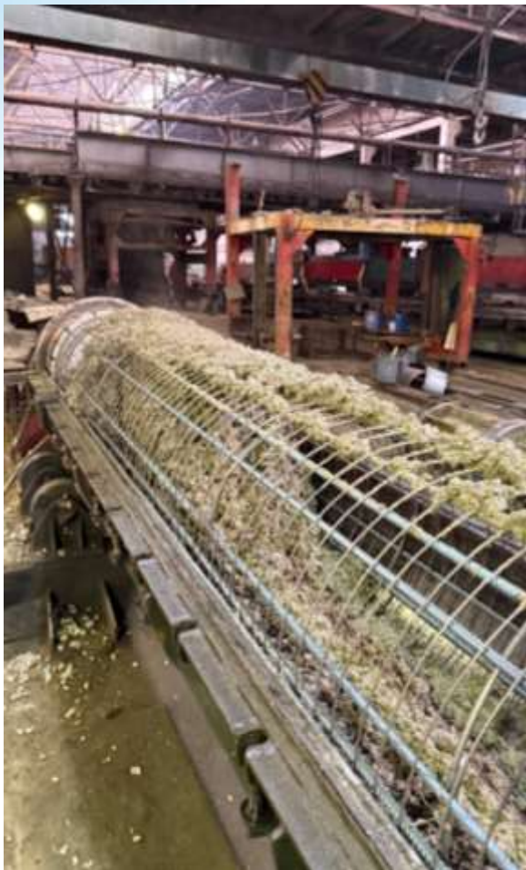
Каркас в опалубке заполнен бетоном
