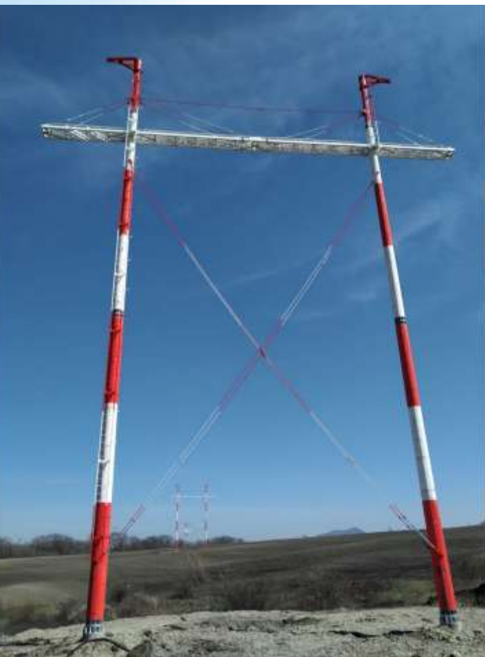
Окраска опор в районе аэропорта
