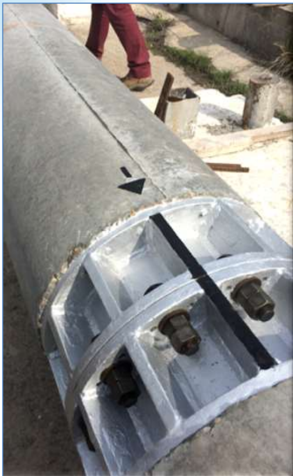
Стойка с внутренним соединительным узлом (с 2014 г.)
