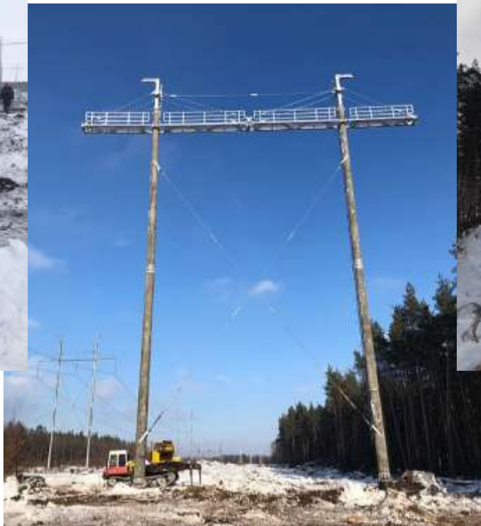
Подъем опоры методом падающей стрелы
