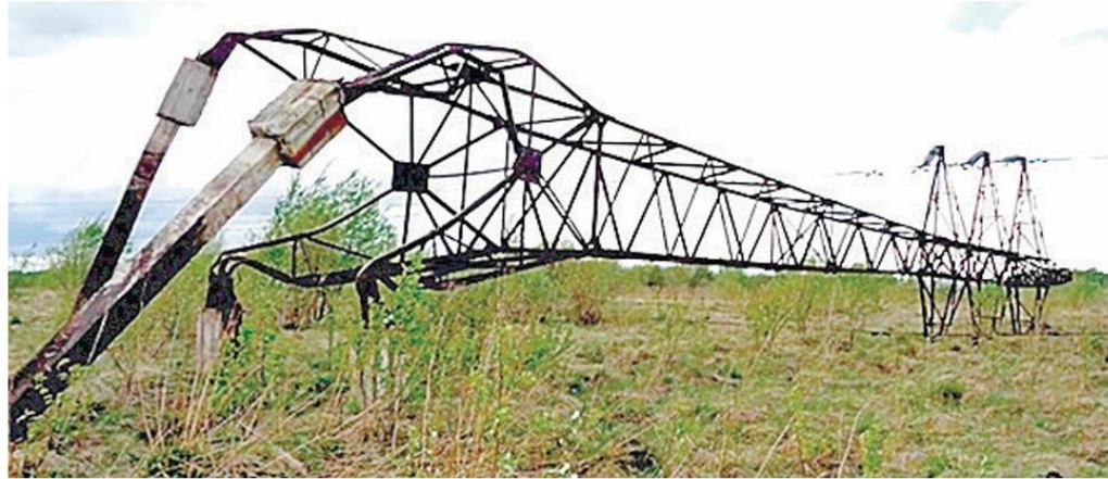
Рис. 11 – Падение двух двухцепных опор ВЛ 110 кВ от сильного сверхрасчетного ветра. Кемер.обл, пос. Яя, 22.05.2015
