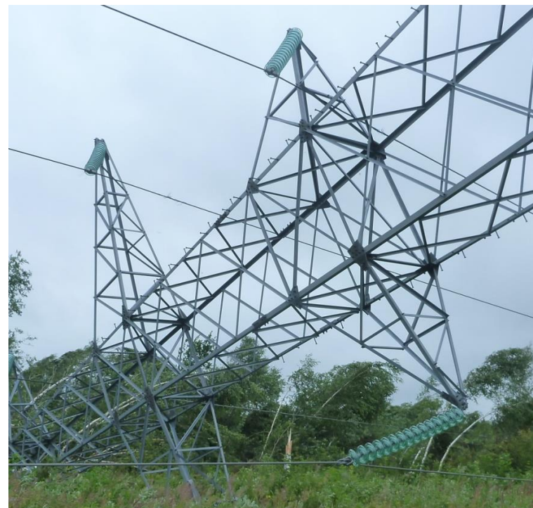
Рис. 6. Упала промежуточная опора №60 на ВЛ220кВ ( \alpha=130^\circ \text{tg } \alpha = 1,1918 )
