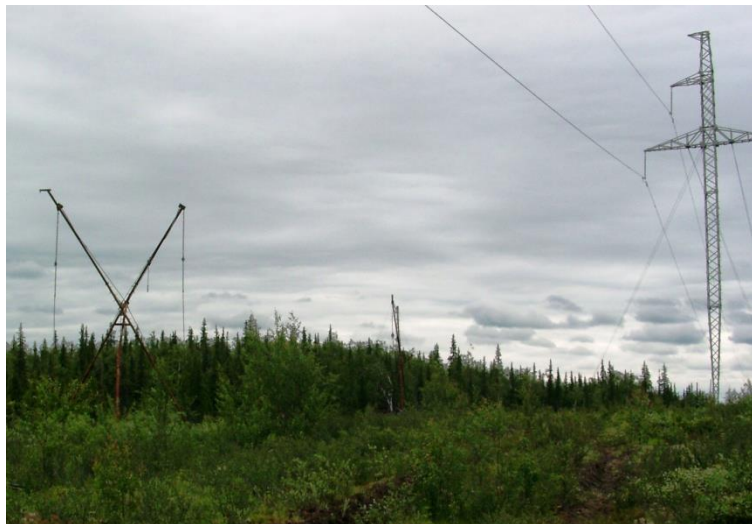
Рис. 7. Специальная резервно-аварийная опора ПРХ220-1М с тросостойкой, доставленная на аварийный пикет вертолетом МИ-6 из г.Печора за три часа (Северный Возей, 29.12.2001)
