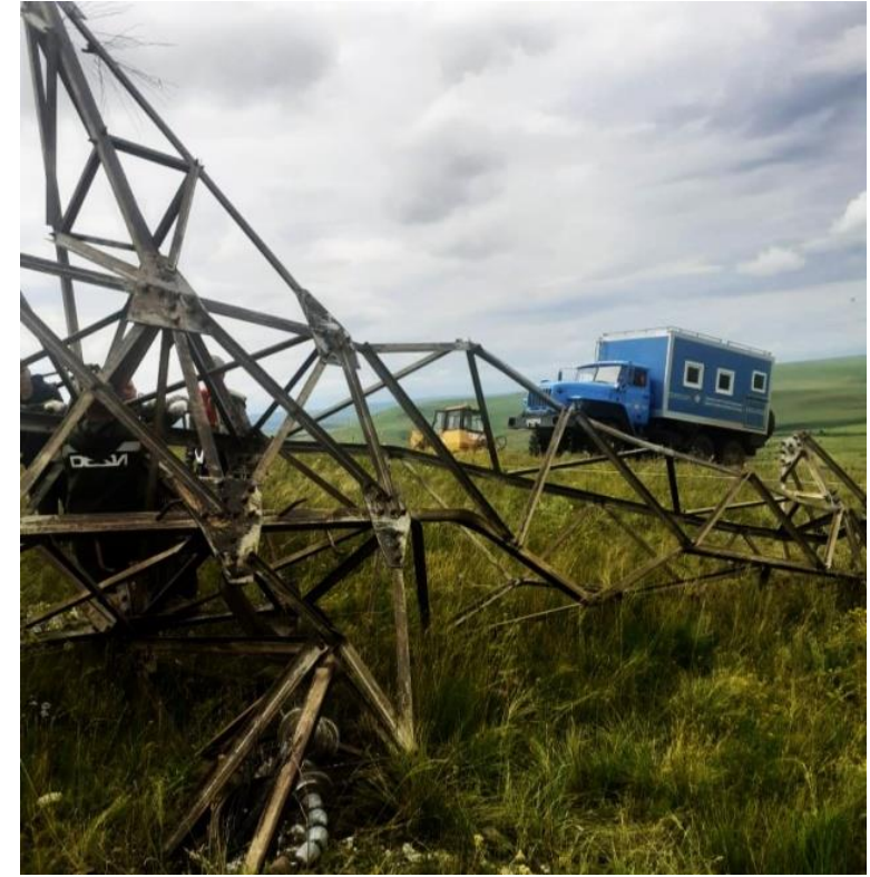
Рис. 2. Аварийное падение промежуточной опоры ВЛ 750 кВ в результате подрыва . 01.05.2023 (Ленобласть, фото губернатора А.Ю.Дрозденко); ВЛ 750 кВ с опорами на оттяжках типа «набла» после восстановления (Ленобласть); падение свободностоящей опоры ВЛ 220 кВ по причине вандализма со снятием раскосов в нижней части опоры (Забайкалье, 2022.09.06)
