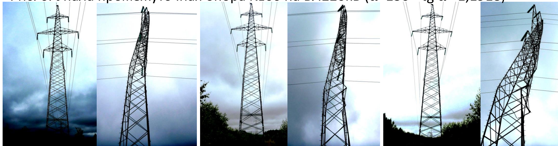
Рис. 6. Упала промежуточная опора №60 на ВЛ220кВ ( \alpha=130^\circ \text{tg } \alpha = 1,1918 )
