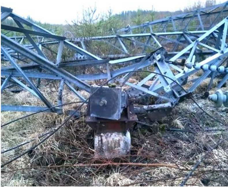
Рис. 2. Аварийное падение промежуточной опоры ВЛ 750 кВ в результате подрыва . 01.05.2023 (Ленобласть, фото губернатора А.Ю.Дрозденко); ВЛ 750 кВ с опорами на оттяжках типа «набла» после восстановления (Ленобласть); падение свободностоящей опоры ВЛ 220 кВ по причине вандализма со снятием раскосов в нижней части опоры (Забайкалье, 2022.09.06)
