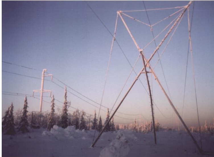
Рис. 7. Специальная резервно-аварийная опора ПРХ220-1М с тросостойкой, доставленная на аварийный пикет вертолетом МИ-6 из г.Печора за три часа (Северный Возей, 29.12.2001)
