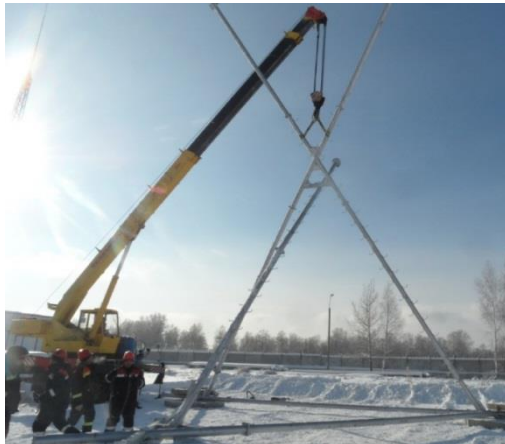
Сборка и монтаж опоры ПРХ220-1М
