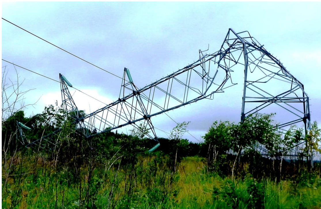
Рис. 6. Упала промежуточная опора №60 на ВЛ220кВ ( \alpha=130^\circ \text{tg } \alpha = 1,1918 )
