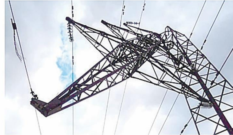
Рис. 11 – Падение двух двухцепных опор ВЛ 110 кВ от сильного сверхрасчетного ветра. Кемер.обл, пос. Яя, 22.05.2015
