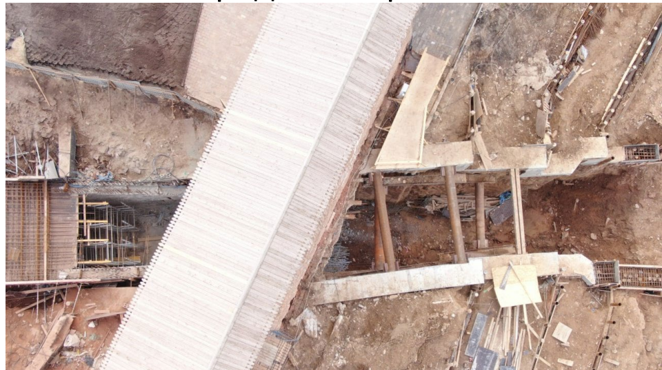
Вид на тоннель сверху
