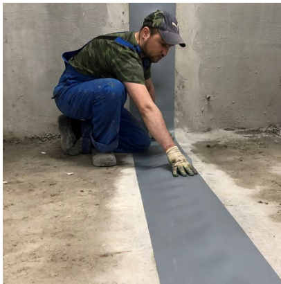
ГЕРМЕТИЗАЦИЯ ШВОВ
