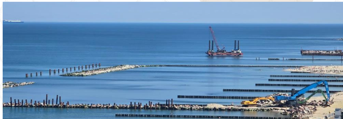
г. Светлогорск, Строительство пляжеудерживающих сооружений
