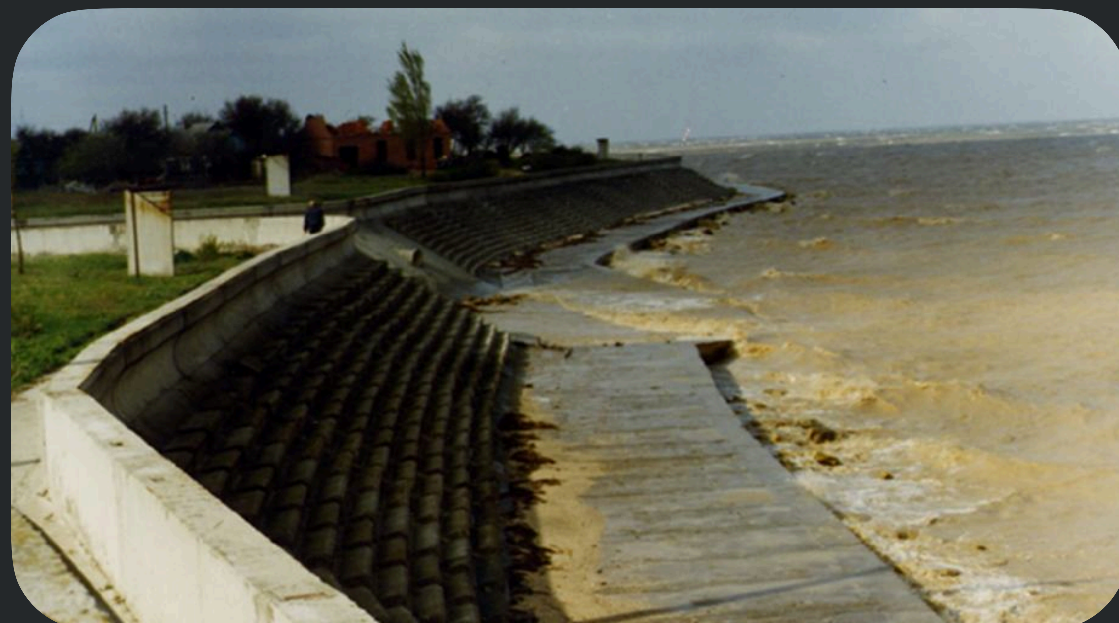
Откосно-ступенчатая стена в Крыму
