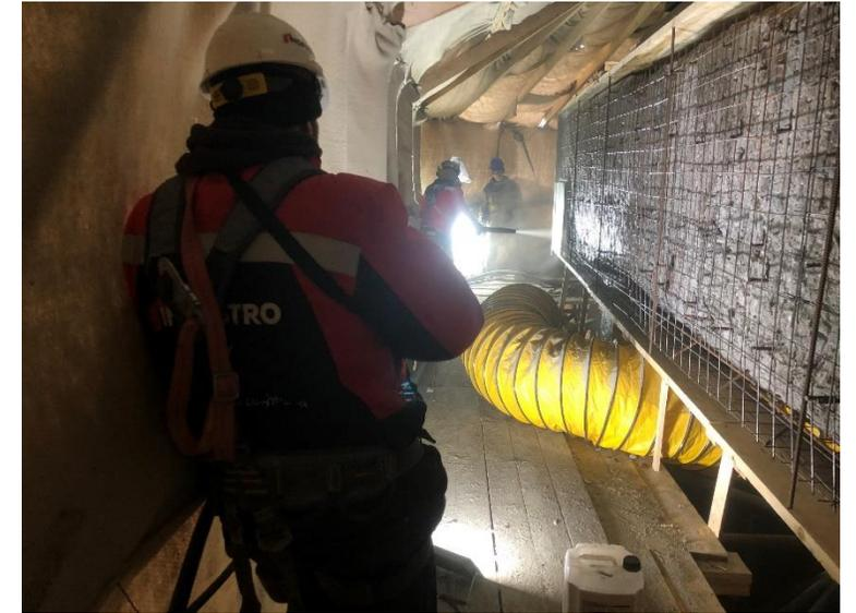
Выполнена работа по ремонту опоры и ригеля Крымского моста материалом Крафтор SC50-2.5 D с металлической фиброй
