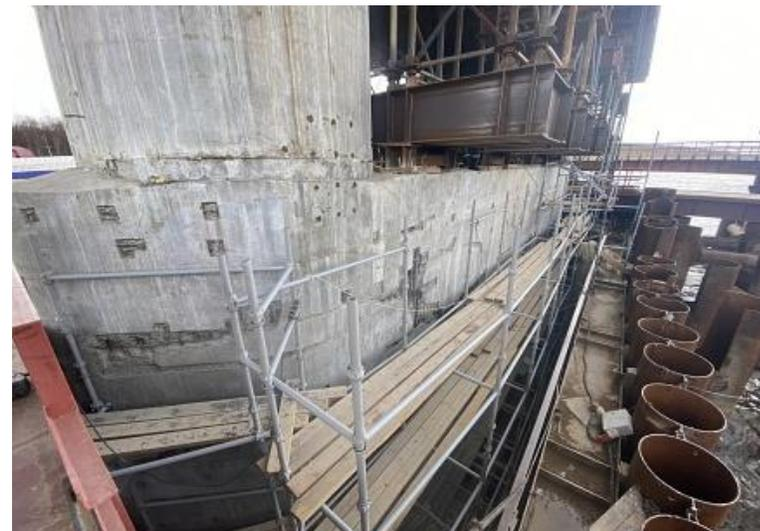
**Ремонт бетона мостовой опоры методом сухого торкретирования через р. Волгу в г. Казань на федеральной трассе М12 - Москва-Казань**
