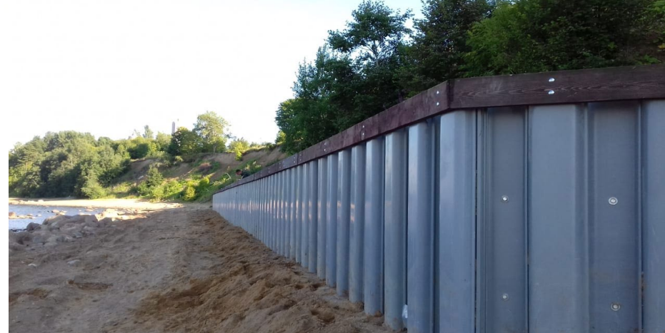
Объект: Подпорная стена Адрес: пос. Лебяжье
