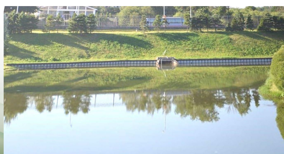
Объект: Подпорная стена Адрес: г. Стрельна
