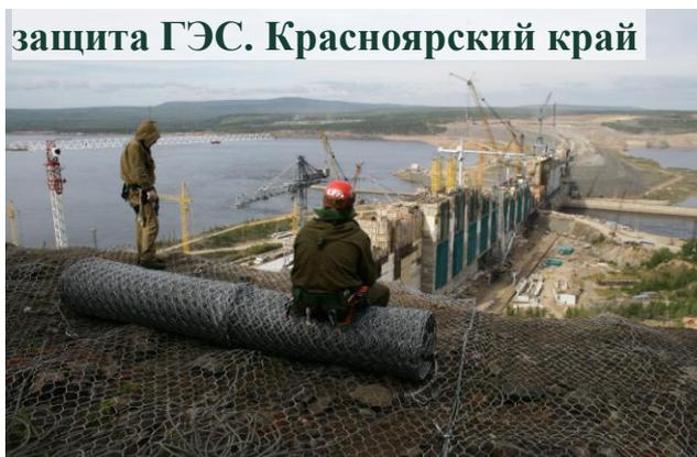
Укрепление всей поверхности склона с помощью сетки и анкеров (с проектным шагом)
