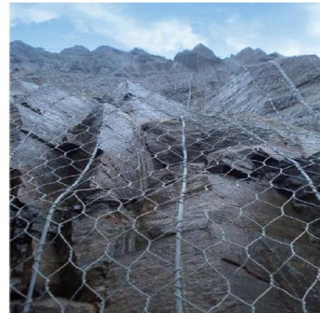
Разработка Маккаферри – система **Стилгрид®** - это комбинация стальной проволочной сетки двойного кручения и высокопрочных (1770 Н/мм<sup>2</sup>) стальных тросов в одной, простой в установке, детали.
