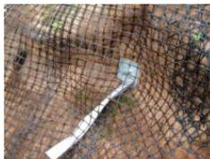
**Дренажные анкеры** для снижения порового давления в грунтовом массиве, дренирования воды из пространства за подпорными стенами.
