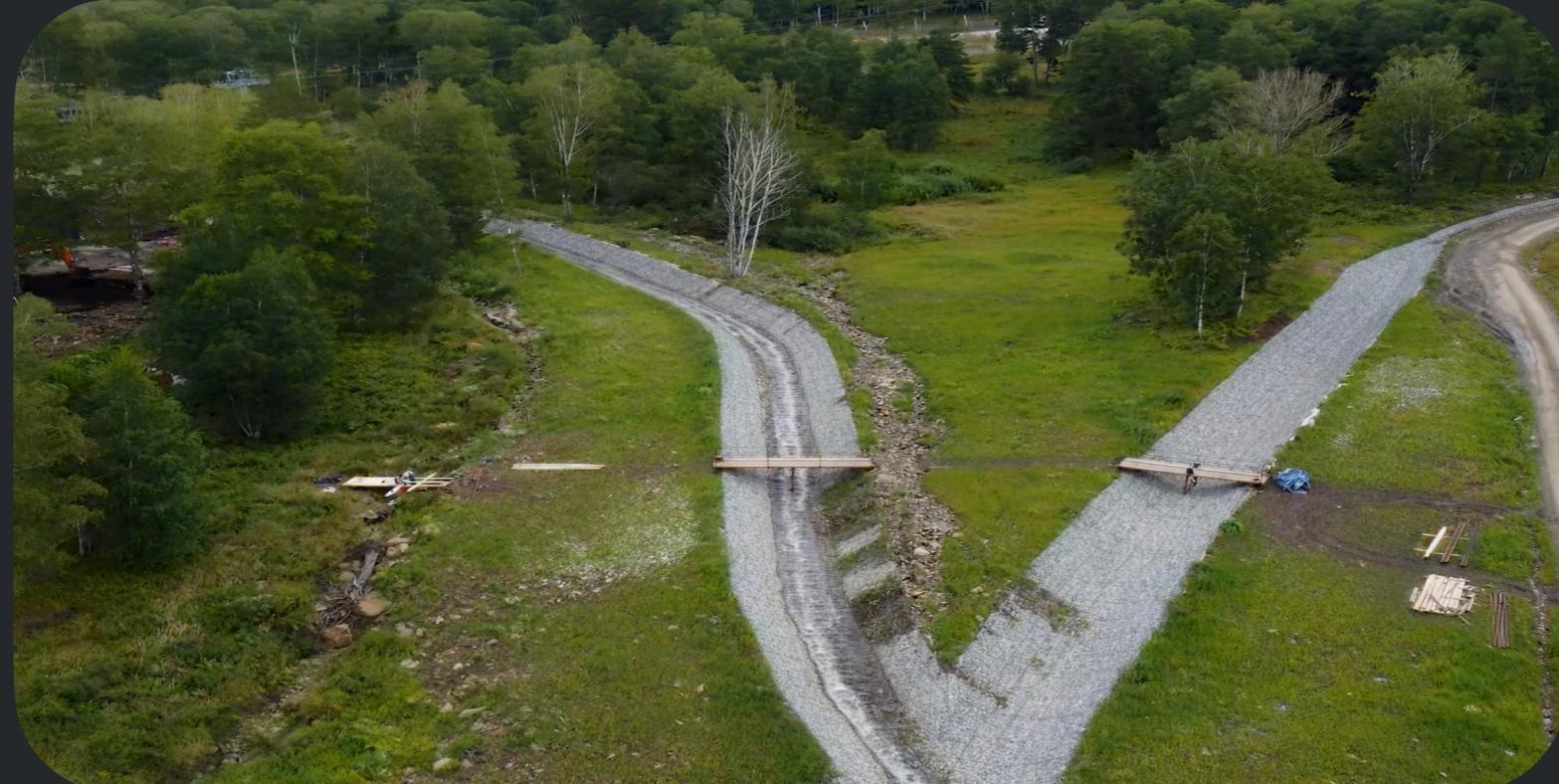
С учётом сложного рельефа и значительных поперечных уклонов, по длине сооружений предусматривались различные конструктивные решения по гашению потока — **многоступенчатые перепады, быстротоки, водобойные колодцы** и т.п.
