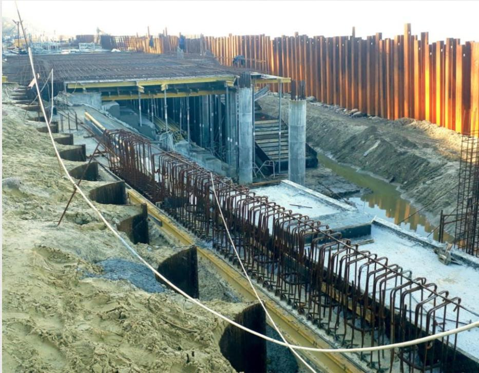
Передний ряд шпунта предотвращает размыв перед сооружением.
