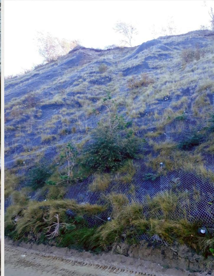
Риски развития оползневых процессов на прилегающих к участку строительства склонах (нагельное крепление склона выполнено в рамках 5 этапа).
