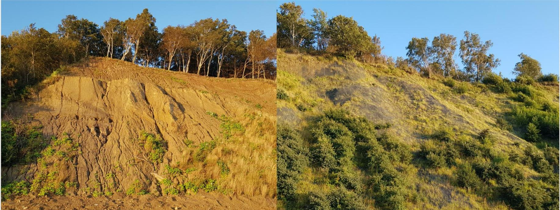
Участок склона на побережье Балтийского моря (г. Светлогорск) без инженерной защиты (слева) и после выполнения нагельного крепления с устройством противоэрозионной покровной системы и восстановленным растительным слоем (справа).
