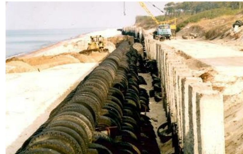
Реконструкция свайно-ячеистой бермы в п. Лесной на Куршской косе, 1995
