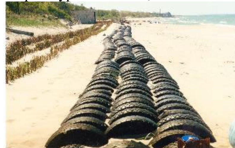
Берегозащитная конструкция на корне Куршской косы, 1993
