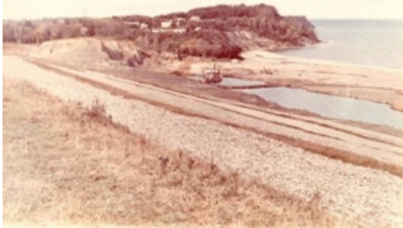
Противооползневые сооружения в п. Филино, 1991
