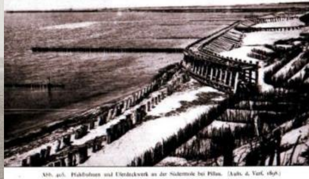
Волноотбойные стены и буны южнее молов порта Пиллау (Балтийск) 1898 г
