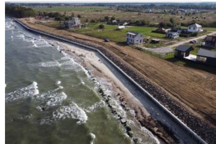
Строительство комплекса БЗС в Куликово 2019-2020 г.
