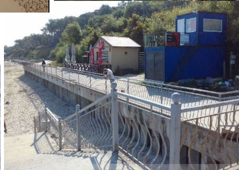
Строительство участка соединения променадов Пионерском, 2012 г.
