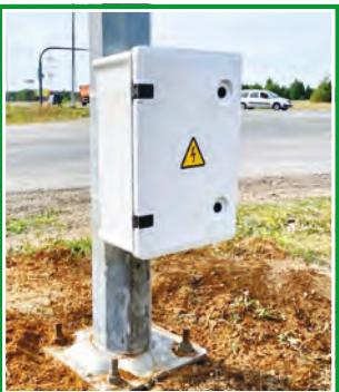
**Композитные кожухи** компании «Берканы» предназначены для защиты электрических соединений, размещённых в основании опор наружного освещения. Они обеспечивают надежную эксплуатацию осветительных систем вдоль дорог, на улицах и других объектах.
