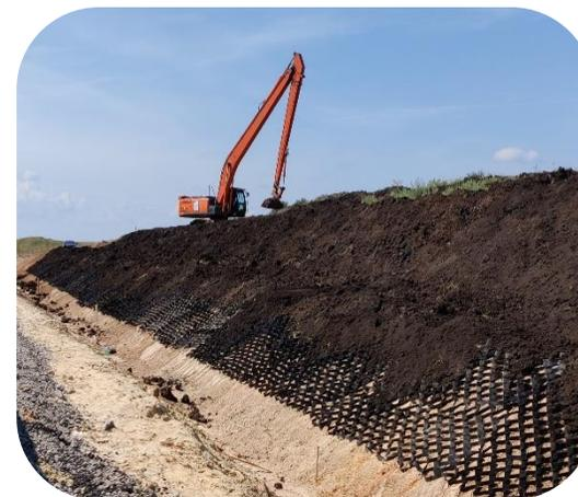
Рис.4. Конструкция укрепления откоса при помощи **ГЕОСТЕП®** в процессе засыпки.
