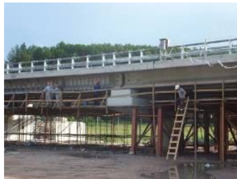
Усиление пролетных строений моста через р. Сторожевая на 24 км трассы «Выборг - Комсомольское - Светлогорск»
