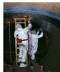
Ремонт водопропускных труб
