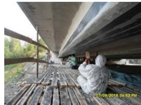
Усиление пролетных строений моста через р. Сторожевая на 24 км трассы «Выборг - Комсомольское - Светлогорск»
