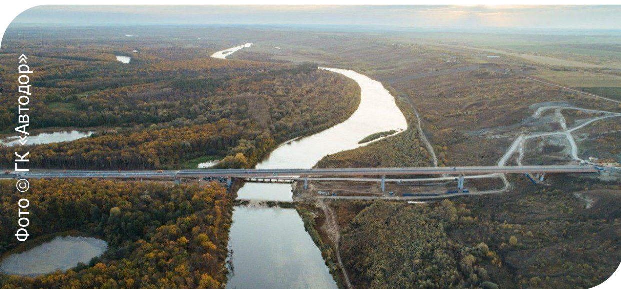
Мостовой переход через реку Суру ТРАССА М-12
