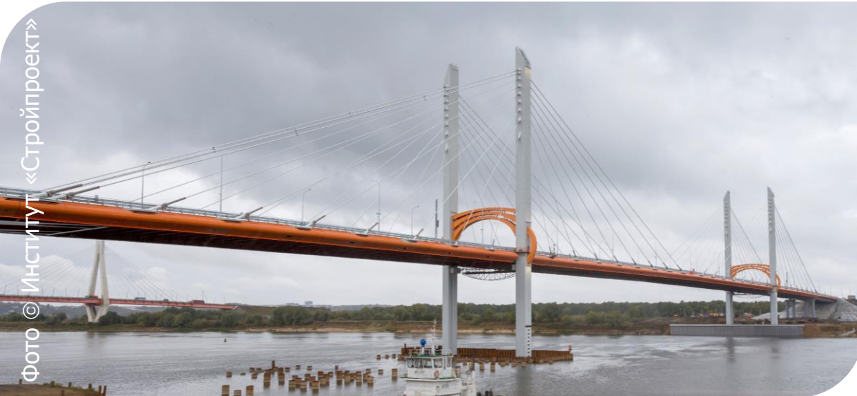
Мост через реку Ока на ПК 2279+00 ТРАССА М-12
