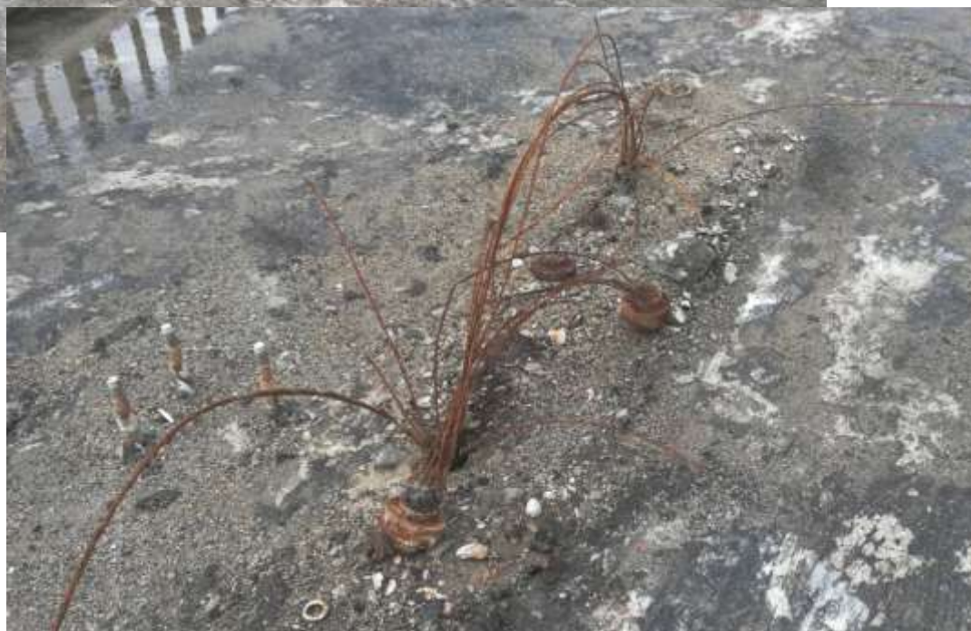
ОБСЛЕДОВАНИЕ КРЕСТОВОЗДВИЖЕННОГО МОСТА ЧЕРЕЗ Р. ДНЕПР В Г. СМОЛЕНСКЕ ПРИ ЕГО РЕМОНТЕ, 2022 Г.
