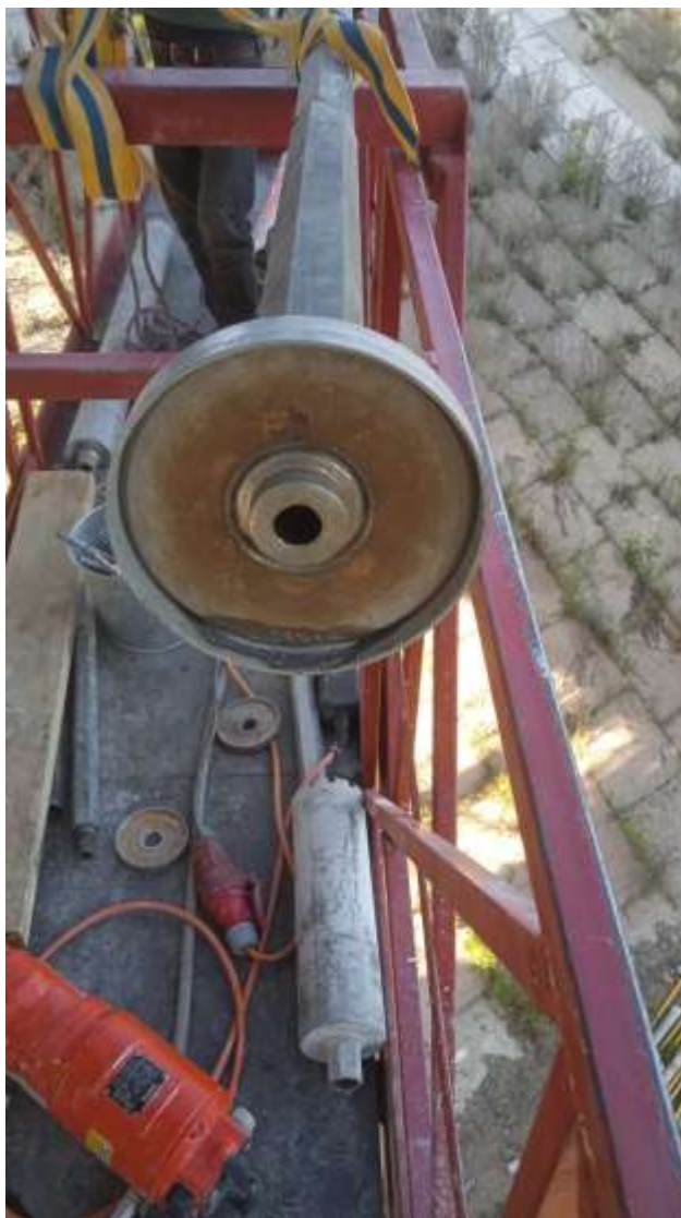
Удлиненные штанги с опорными шайбами, г.Смоленск, сентябрь 2024г.
