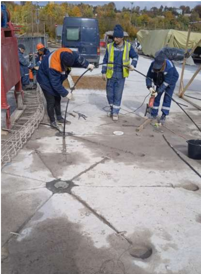
АНКЕРОВКА ПРЯДЕЙ В ПЛИТЕ ПРОЛЕТНОГО СТРОЕНИЯ ОТ ВЕРТИКАЛЬНОГО ПУЧКА УСИЛЕНИЯ КОРОБКИ НАДОПОРНОГО СЕЧЕНИЯ НА БЛОКАХ ПРК – «ЛОТОС»
