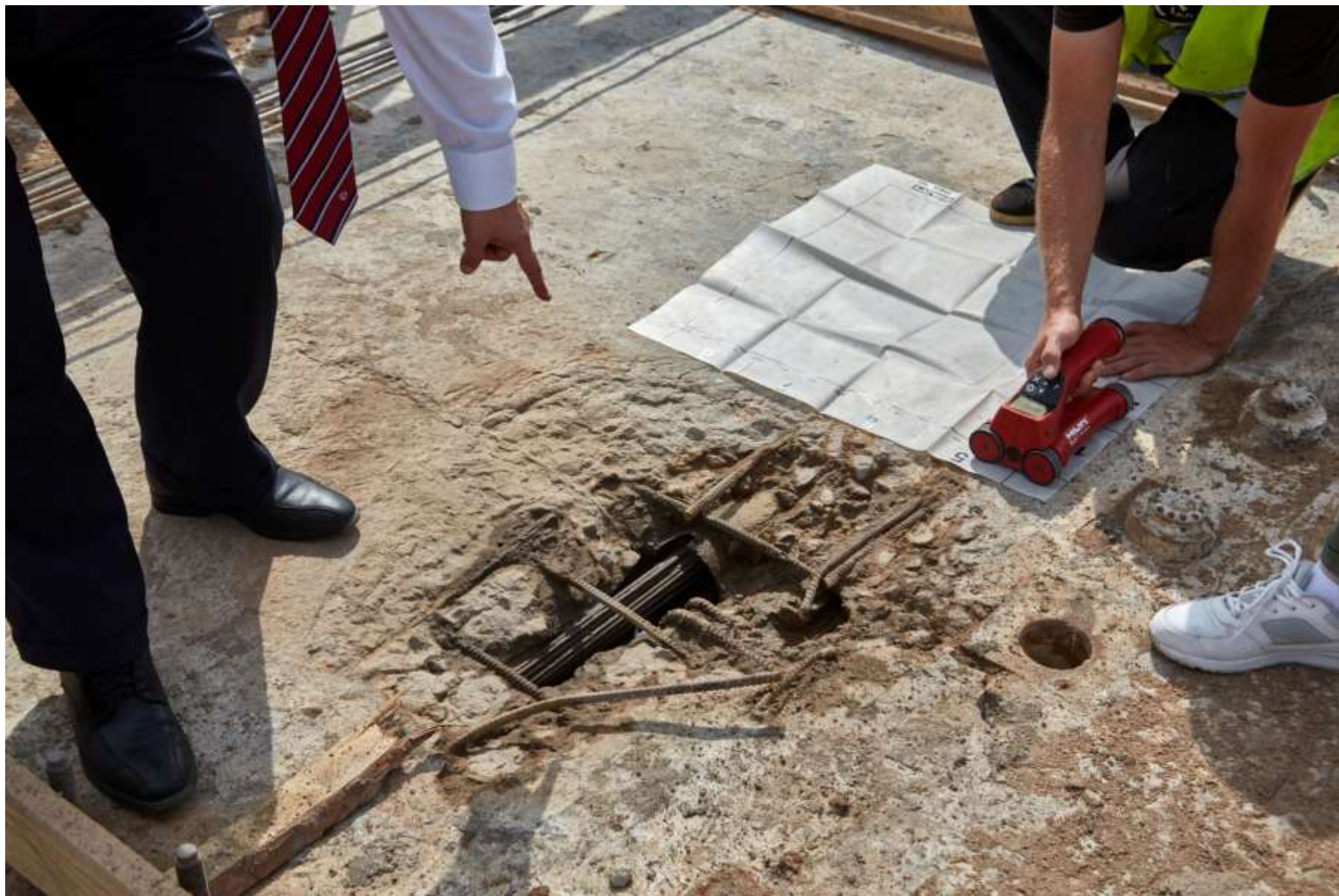
ОБСЛЕДОВАНИЕ КРЕСТОВОЗДВИЖЕННОГО МОСТА ЧЕРЕЗ Р. ДНЕПР В Г. СМОЛЕНСКЕ ПРИ ЕГО РЕМОНТЕ, 2022 Г.
