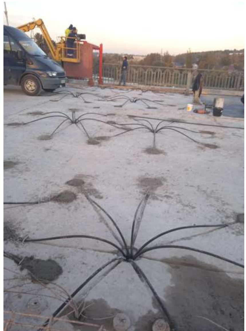
АНКЕРОВКА ПРЯДЕЙ В ПЛИТЕ ПРОЛЕТНОГО СТРОЕНИЯ ОТ ВЕРТИКАЛЬНОГО ПУЧКА УСИЛЕНИЯ КОРОБКИ НАДОПОРНОГО СЕЧЕНИЯ НА БЛОКАХ ПРК – «ЛОТОС»
