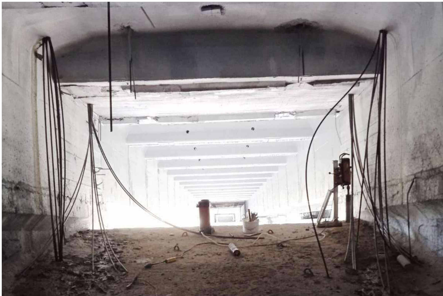
КАПИТАЛЬНЫЙ РЕМОНТ КРЕСТОВОЗДВИЖЕННОГО МОСТА ЧЕРЕЗ Р. ДНЕПР В Г. СМОЛЕНСКЕ, 2022 Г.
