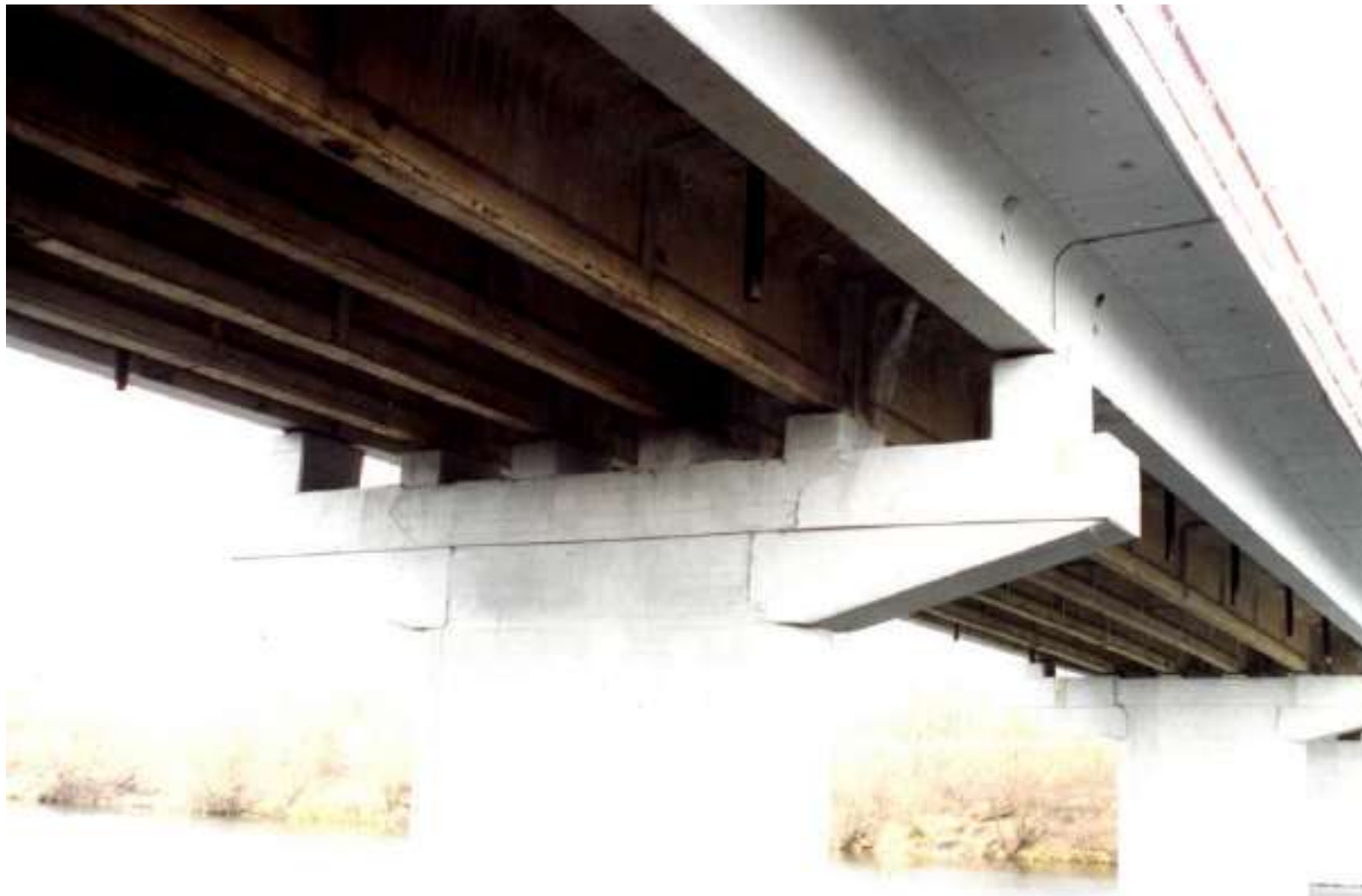
КОНСТРУКЦИЯ МОСТА ПОСЛЕ УШИРЕНИЯ
