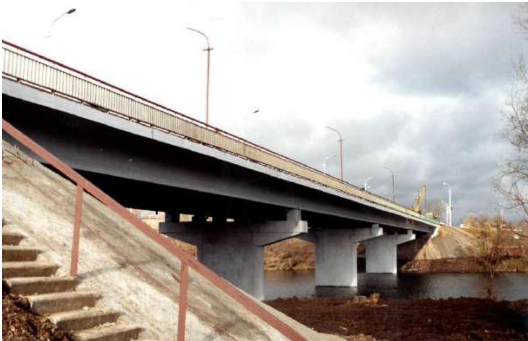
КОНСТРУКЦИЯ МОСТА ПОСЛЕ УШИРЕНИЯ
