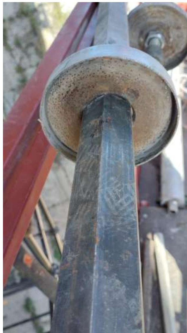
Удлиненные штанги с опорными шайбами, г.Смоленск, сентябрь 2024г.
