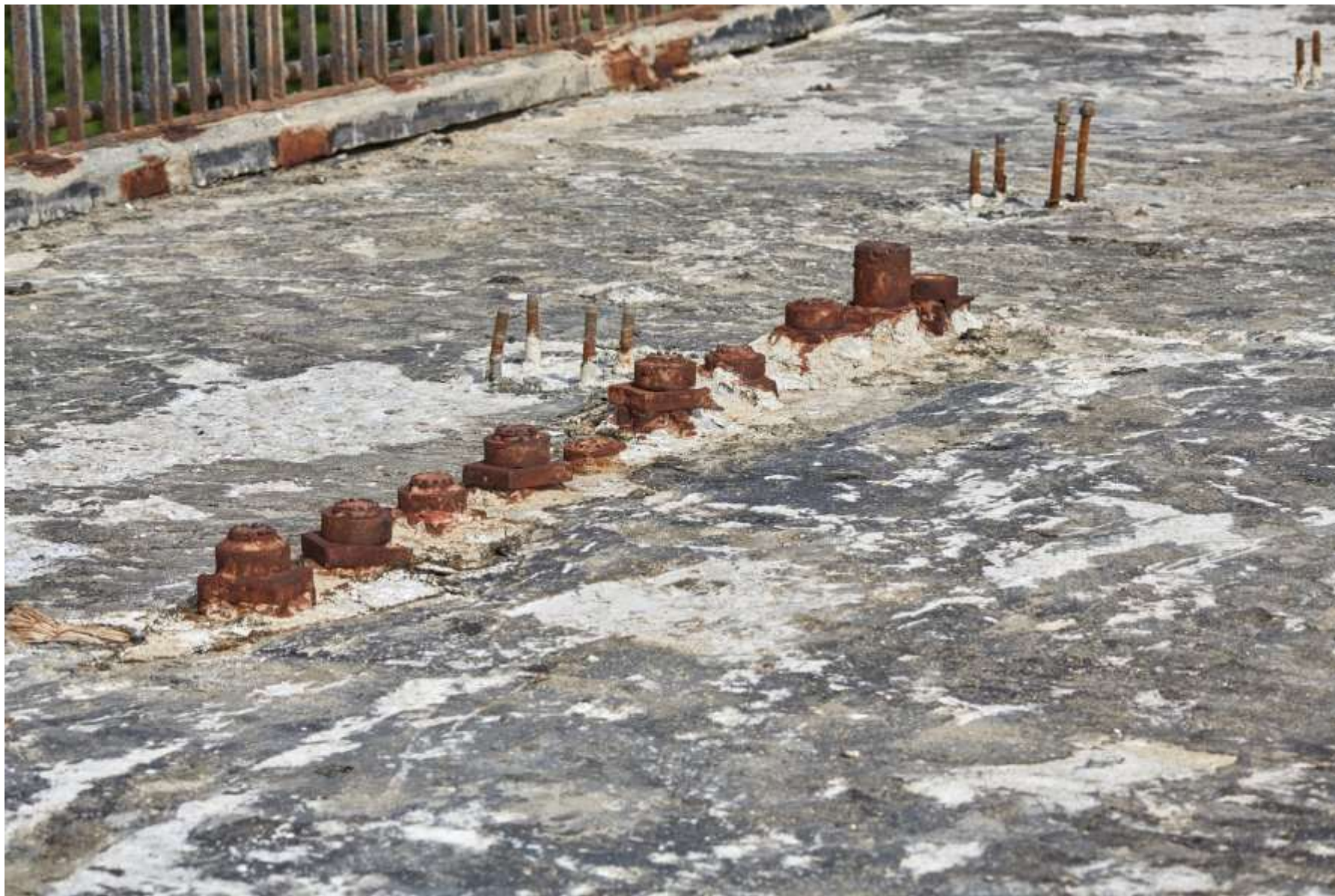
ОБСЛЕДОВАНИЕ КРЕСТОВОЗДВИЖЕНСКОГО МОСТА ЧЕРЕЗ Р. ДНЕПР В Г. СМОЛЕНСКЕ ПРИ ЕГО РЕМОНТЕ, 2022 Г.
