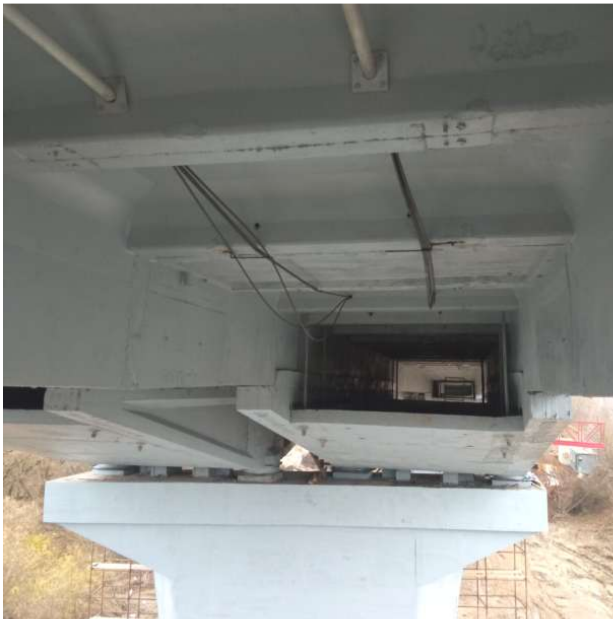
КАПИТАЛЬНЫЙ РЕМОНТ КРЕСТОВОЗДВИЖЕНСКОГО МОСТА ЧЕРЕЗ Р. ДНЕПР В Г. СМОЛЕНСКЕ, 2022 Г.
