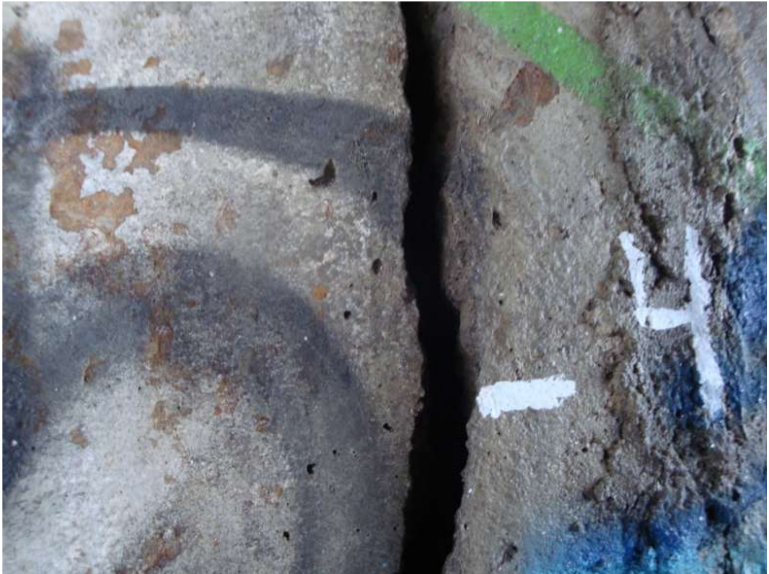
Раскрытие трещины
