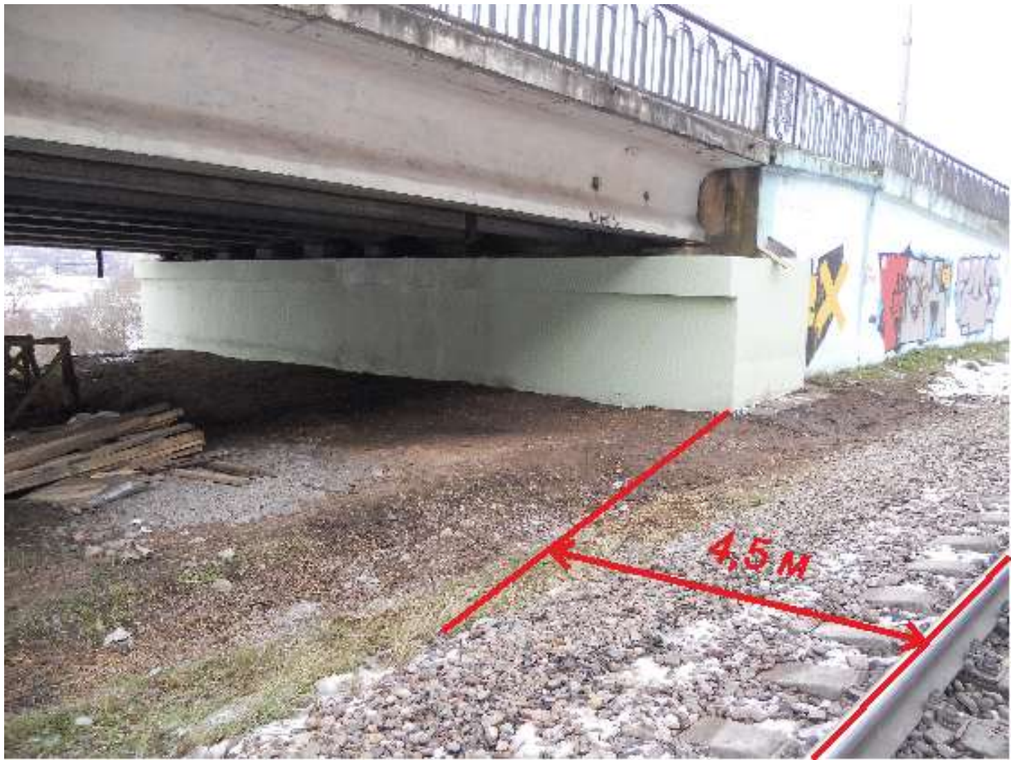
Расстояние от головки рельса до боковой стенки устоя
