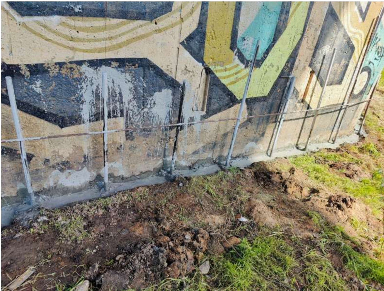
Усиление основания ударно-инъекционными сваями
