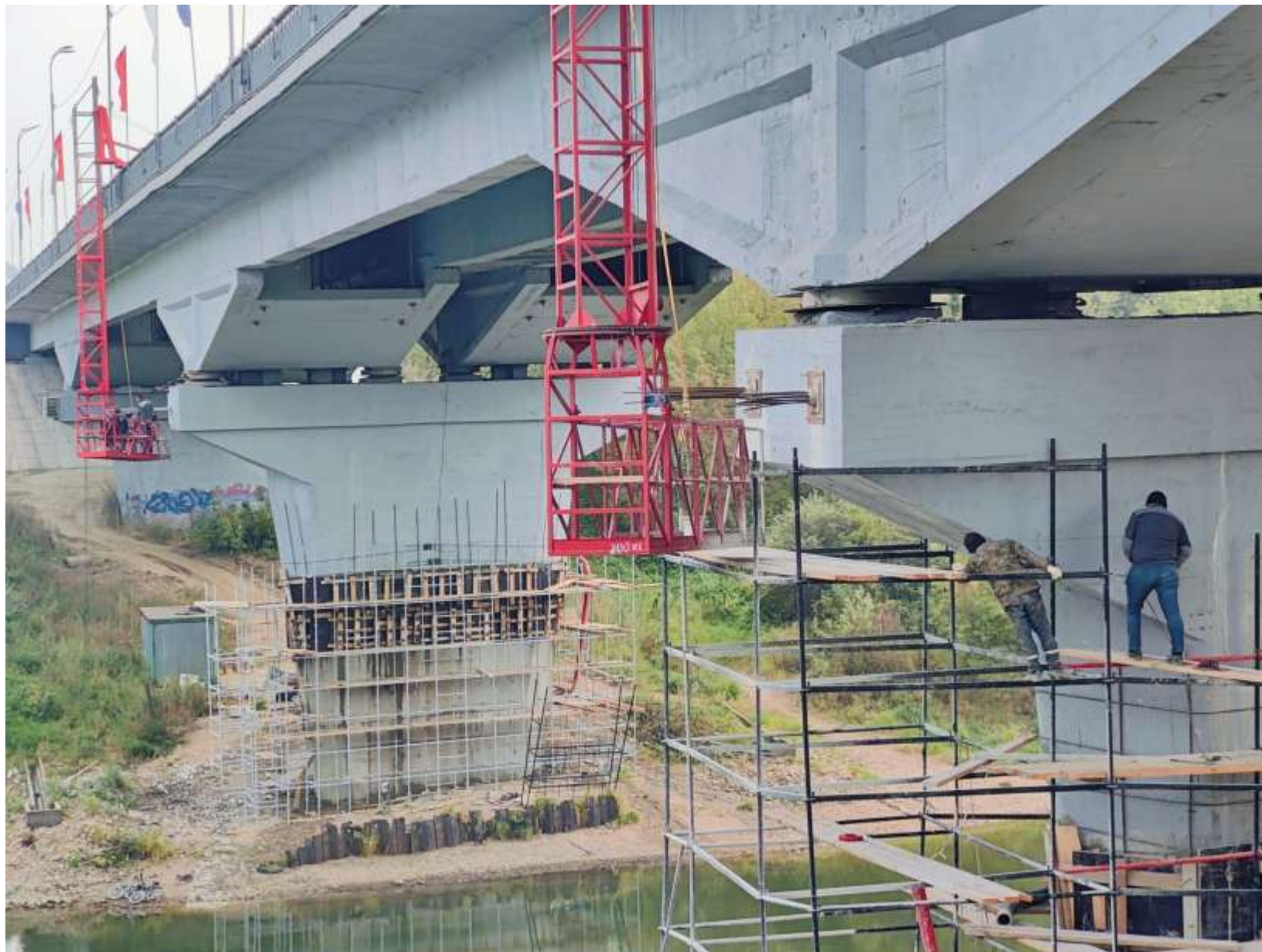
Работы выполнялись с подвесных платформ
