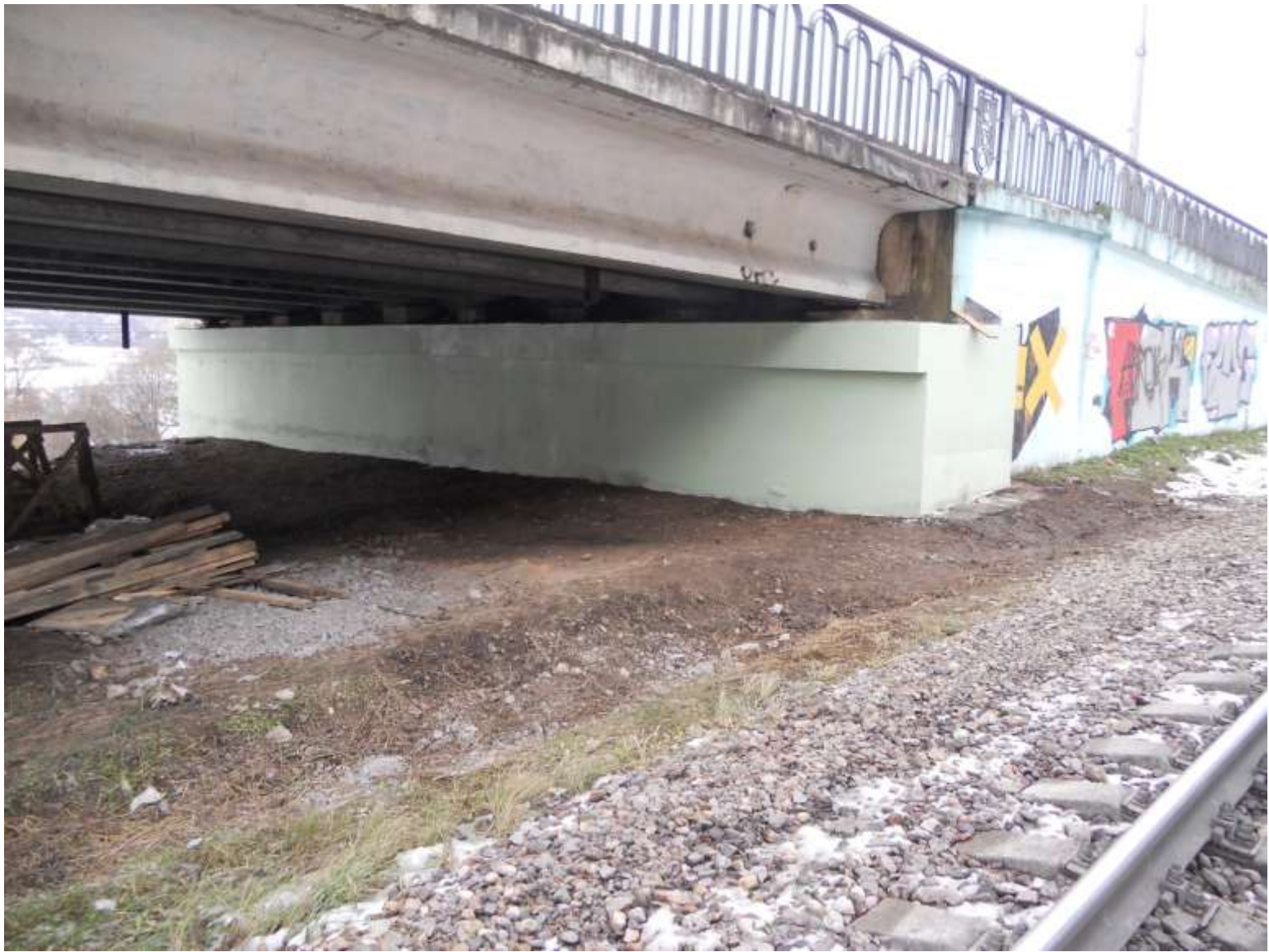
Устой после ремонта – лето 2011 г.
