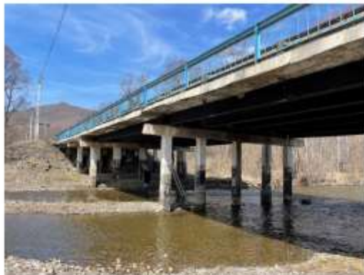
Фото Г.3 – Общий вид мостового сооружения
