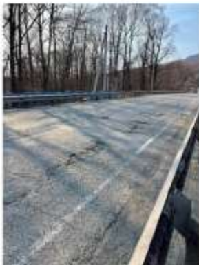
Фото Г.1 – Общий вид мостового сооружения
