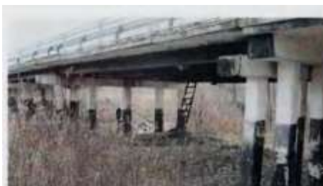
Рисунок 8.10 – Вид снизу на сталежелезобетонное экспериментальное пролетное строение моста. На нижнем поясе крайней балки видны упоры для стеклопластиковой арматуры
