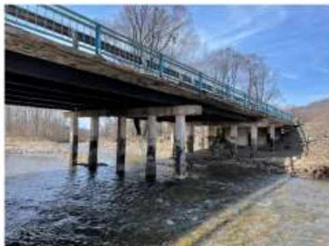
Фото Г.2 – Общий вид мостового сооружения
