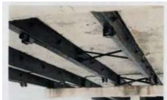
Рисунок 8.11 – Вид снизу на металлические балки, преднапряженные стеклопластиковой арматурой. На нижних поясах видны устройства (анкеры-упоры) для натяжения и закрепления пучков преднапряженной стеклопластиковой арматуры
