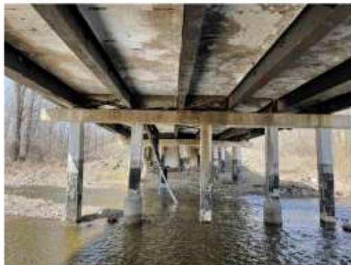
Фото Г.4 – Общий вид мостового сооружения
