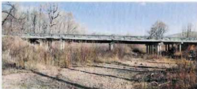
Рисунок 8.9 – Общий вид моста через реку Тигровую на автодороге Шкотово – Партизанск (Приморский край)
