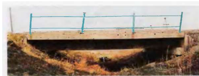
Рисунок 8.2 – Общий вид моста с несущими конструкциями из клееной древесины, армированными преднапряженной стеклопластиковой арматурой и объединенными в совместную работу с железобетонной плитой проезда
