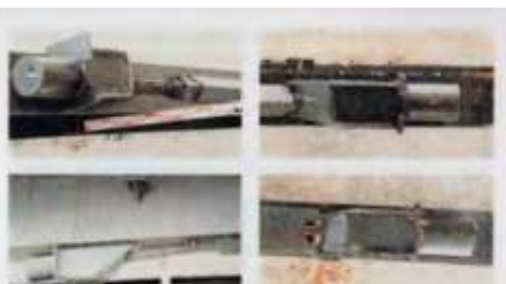
Рисунок 8.12 – Фрагменты нижнего пояса балок (вид снизу) с упорами и анкерами для натяжения и закрепления стержней стеклопластиковой арматуры
