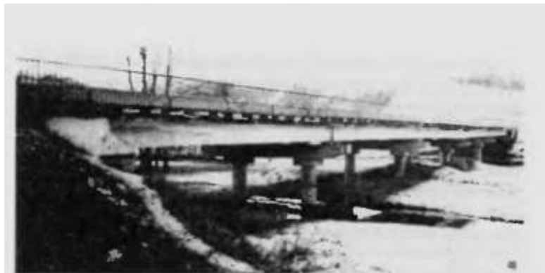
Рисунок 8.5 – Вид моста через реку Хинган в г. Облучье (ЕАО) с левого берега с верховой стороны
