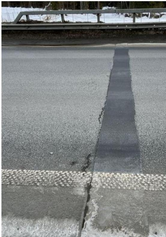
Трещина в уложенном а/б покрытием над
