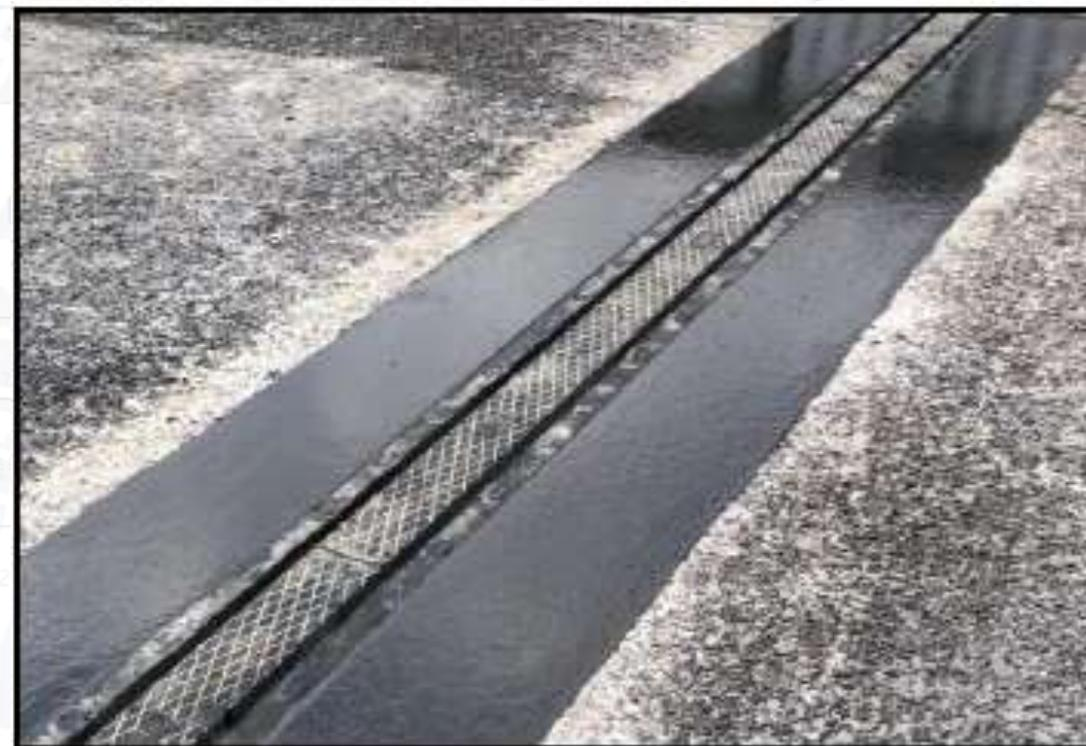
ПОЛИМЕРБЕТОННОЕ ПОКРЫТИЕ ПРИШОВНОЙ ЗОНЫ ДЕФОРМАЦИОННОГО ШВА
