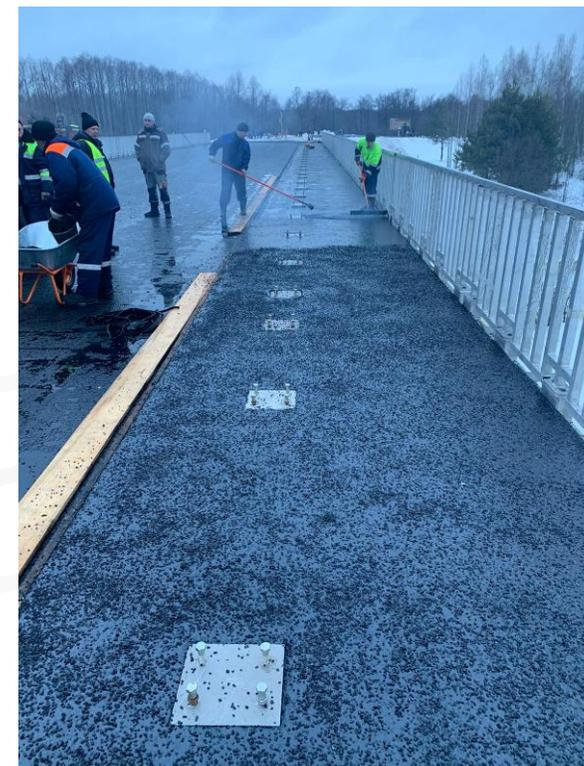
Наклейка стыковочной ленты «Брит» на технологических стыках и примыканиях к деформационным швам
