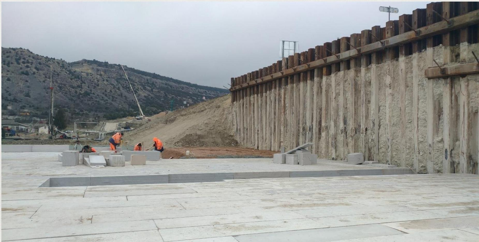
Возведение легкой насыпи разделено на несколько этапов с устройством по оси дороги шпунтового ограждения.
