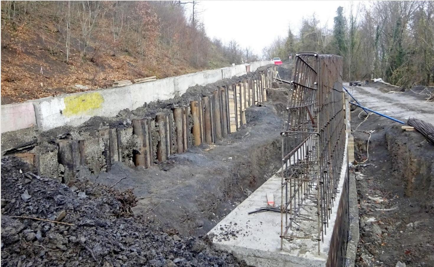
Для предотвращения развития оползневых процессов возможно устройство временных подпорных стен (шпунтовых, из свай малого диаметра), которые отделяют деформированный участок от нетронутого.
