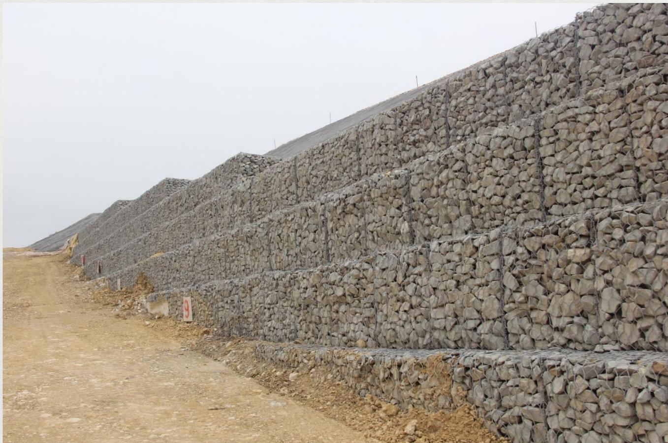
Для сокращения габарита подхода к мосту принято решение об устройстве подпорной стеры. Наиболее рациональным решением стала армогрунтовая стена с лицевой поверхностью из габионов.
