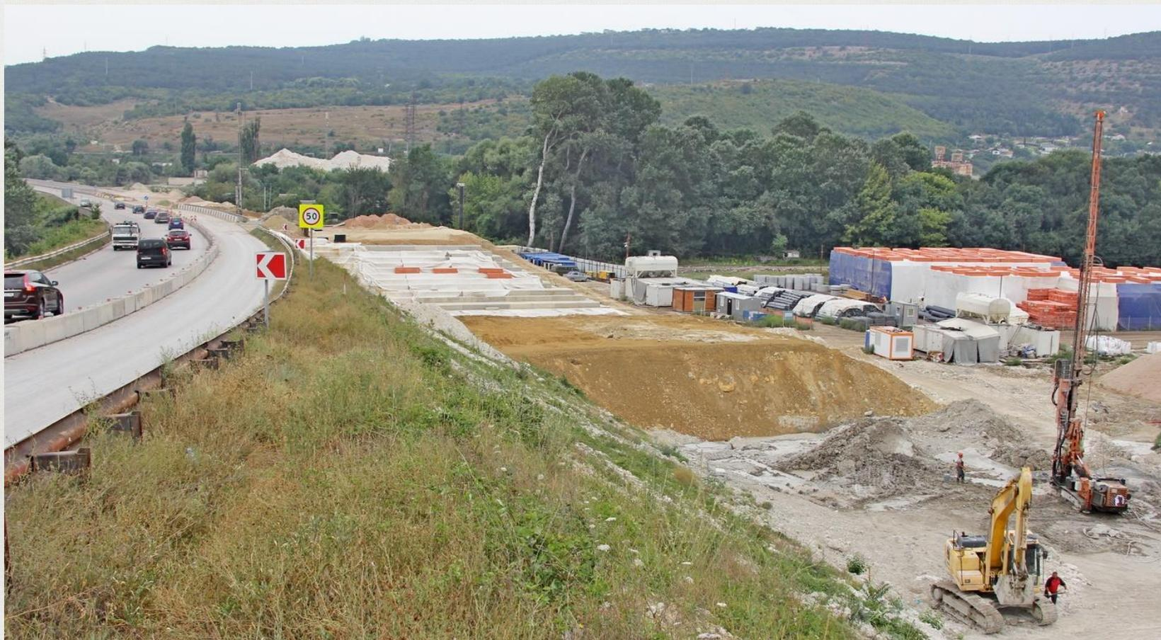
Модификация грунта основания под песчаной насыпью методом струйной цементации (Jet Grouting).
