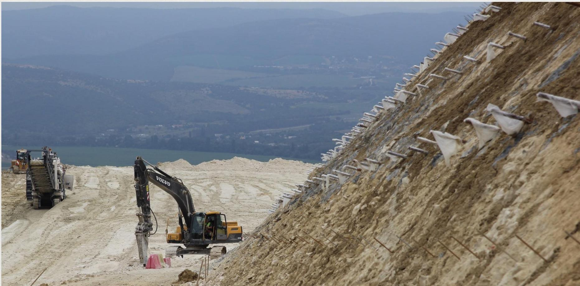
**Нагельное крепление** – эффективный метод защиты от оползневых явлений, обеспечения устойчивости склонов (откосов). Подразумевает пространственное армирование массива грунтовыми нагелями GEOIZOL-MP.
