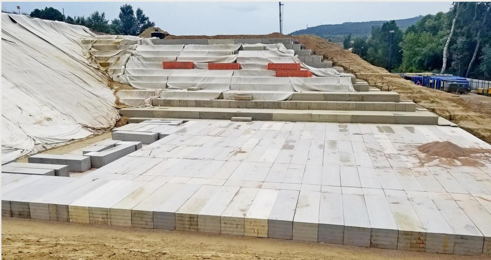
Легкая насыпь из блоков экструдированного полиполистирола (ЭПС)
