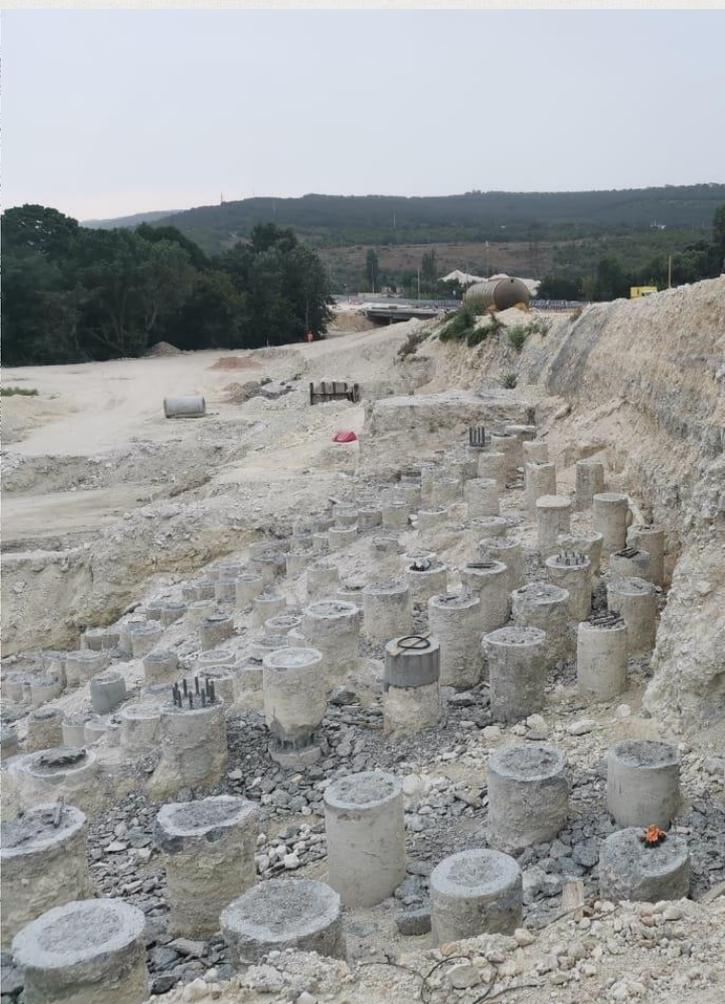
В зоне размещения инженерных коммуникаций выполнены сваи по технологии непрерывного полого шнека (CFA).
