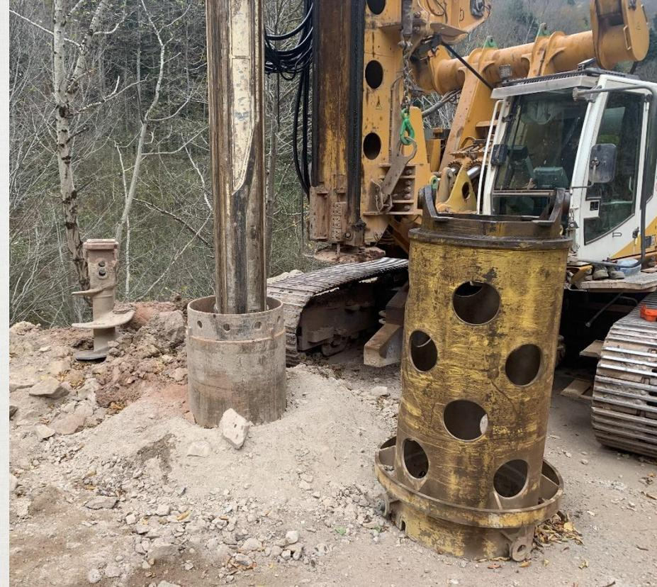
В качестве постоянного сооружения целесообразно использование свай в виде стальных труб, которые сразу включаются в работу.
