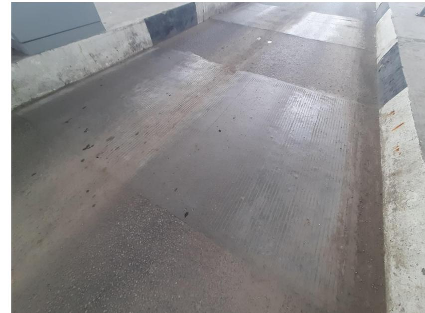
Полное отсутствие износа полотна после года эксплуатации
