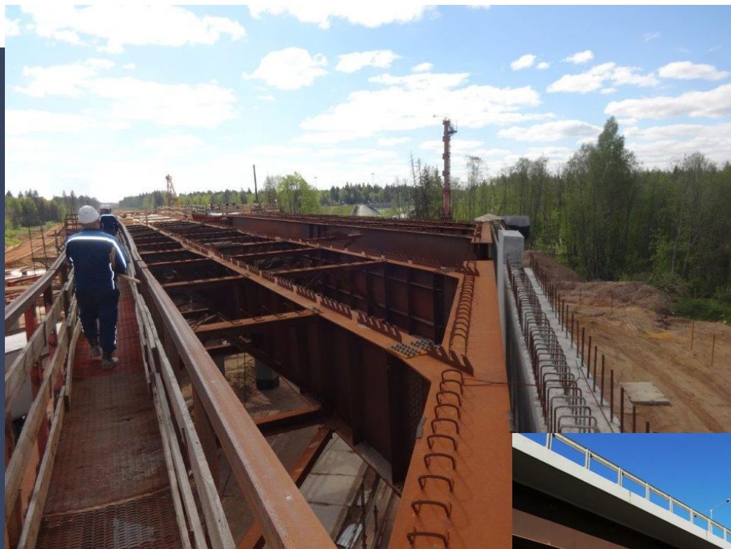
Фото путепровода, 2022 г.
