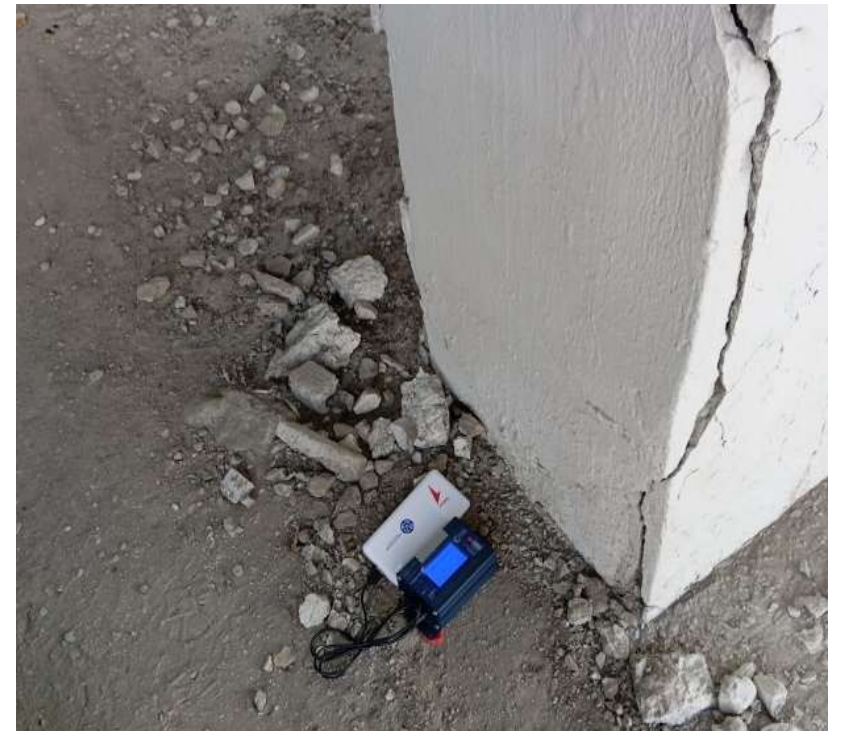
Вибродатчик в основании опоры
