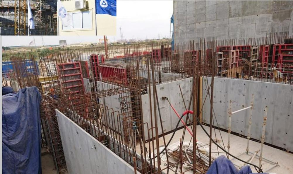
Применение несъемной опалубки из СПФБ для блоков АЭС (АЭС «Охома», Hitachi, Япония)
