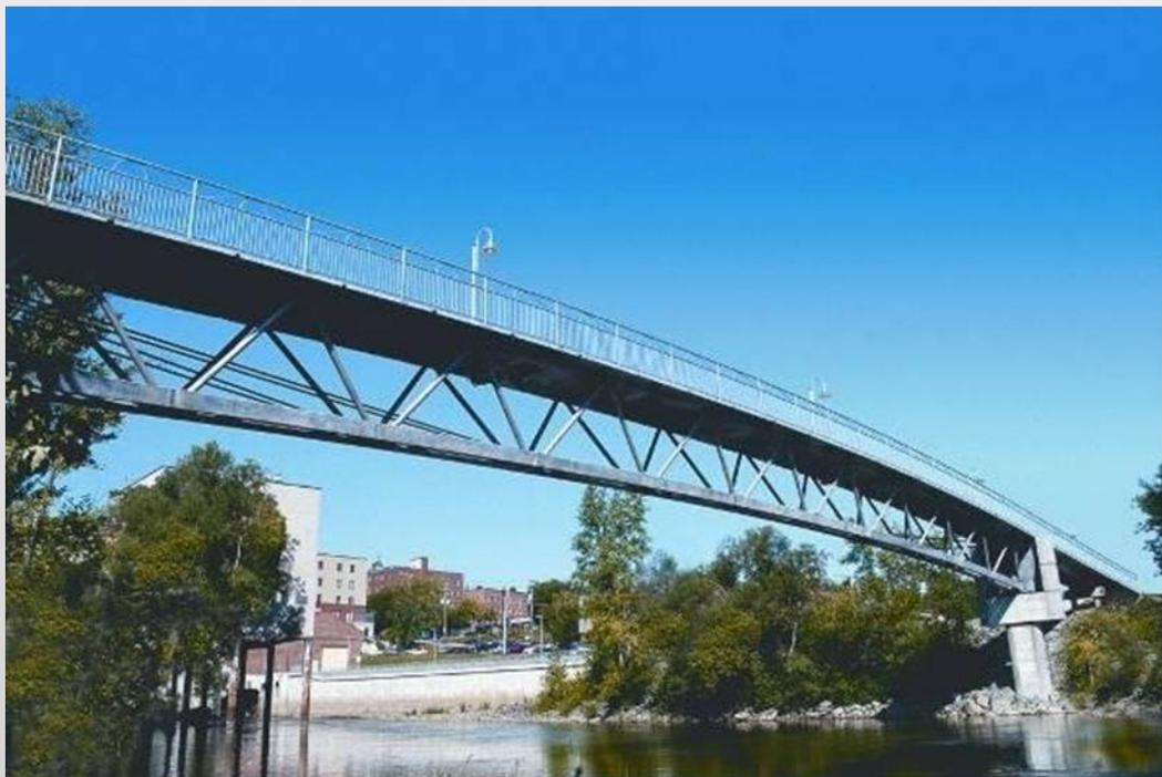
Пешеходный мост с плитой из фибробетона, Канада
