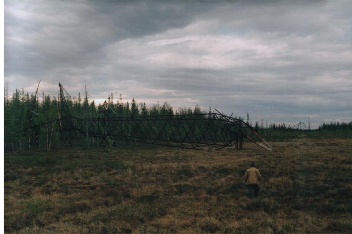
Рисунок 5.2 – Упавшая промежуточная опора вследствие потери несущей способности свай при выдергивании
