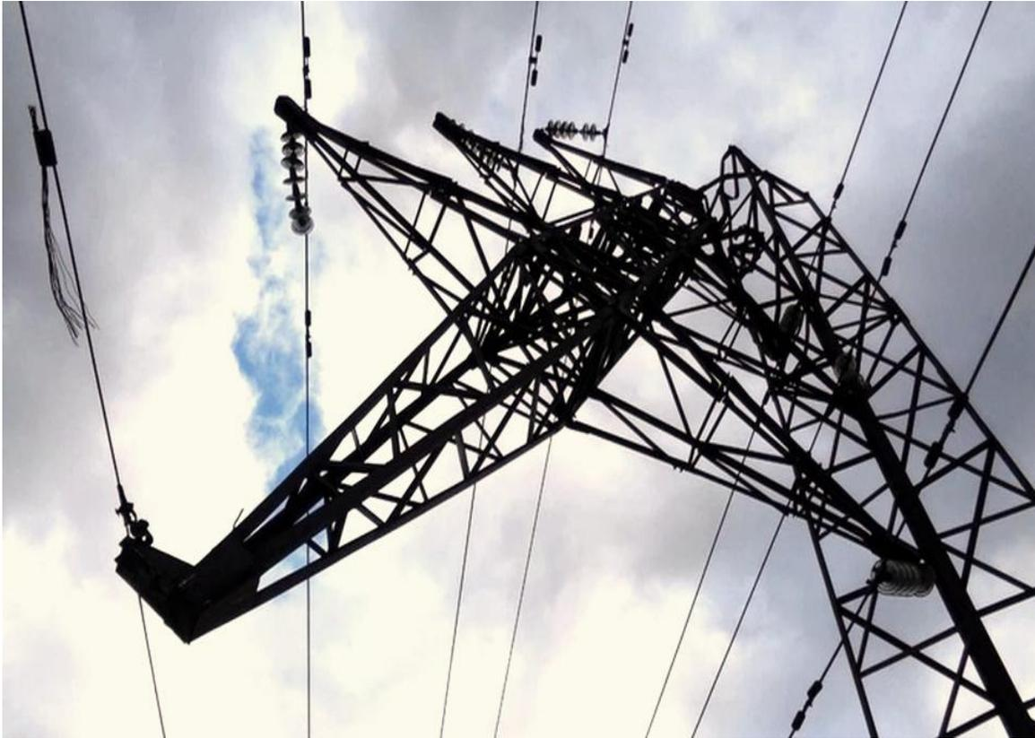
Рисунок 5.1 – Разрушенная промежуточная опора ВЛ 110 кВ вследствие потери устойчивости сжатого пояса под нижней траверсой
