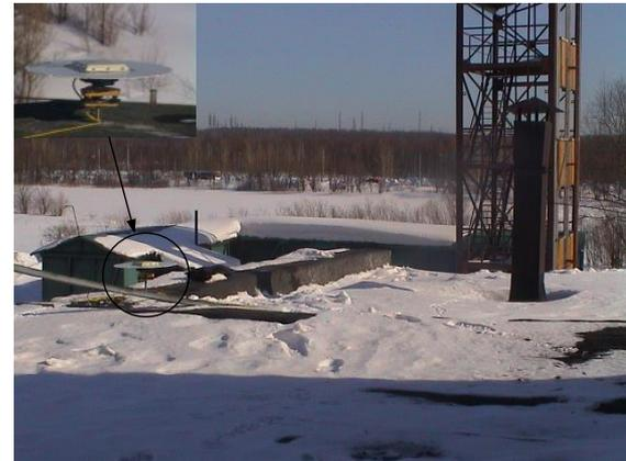
Создание высокоточной комплексной высокоточной мониторинговой сети в горно-подрабатываемой территории г. Березники, включающей геодезическую спутниковую систему, инклинометры и акселерометры
