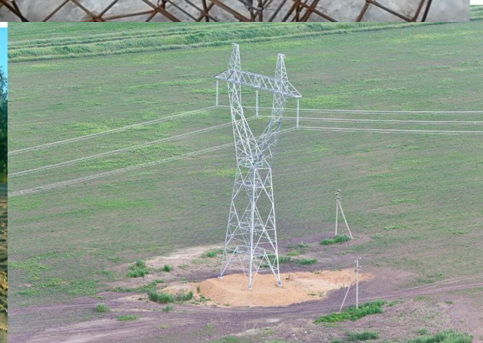
Разрушение фундаментов опор ВЛ
