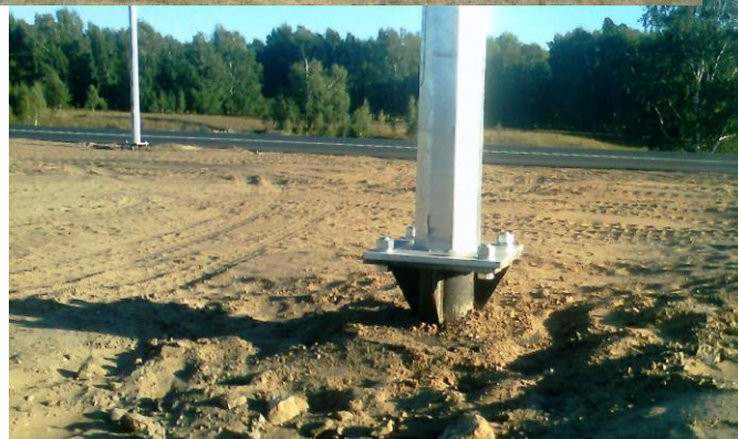
Разрушение фундаментов опор ВЛ
