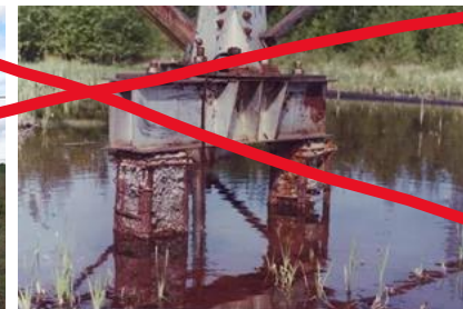
Разрушение фундаментов опор ВЛ
