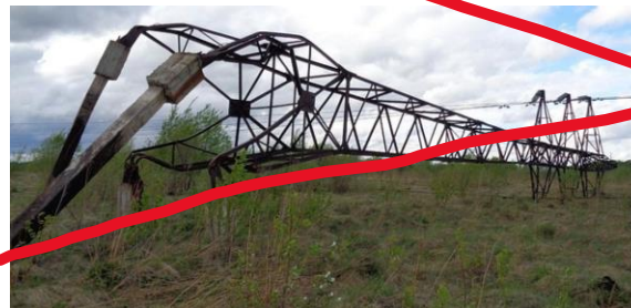
Разрушение фундаментов опор ВЛ
