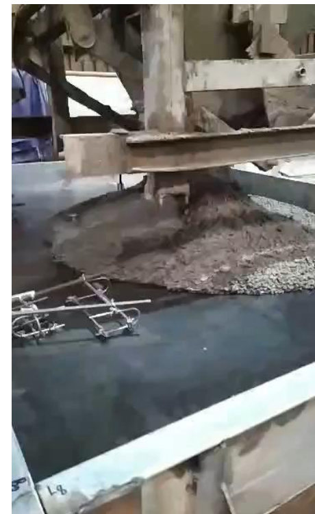
Укладка в форму СУБС
