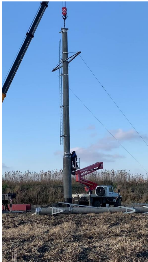
Монтаж средней секции опоры
