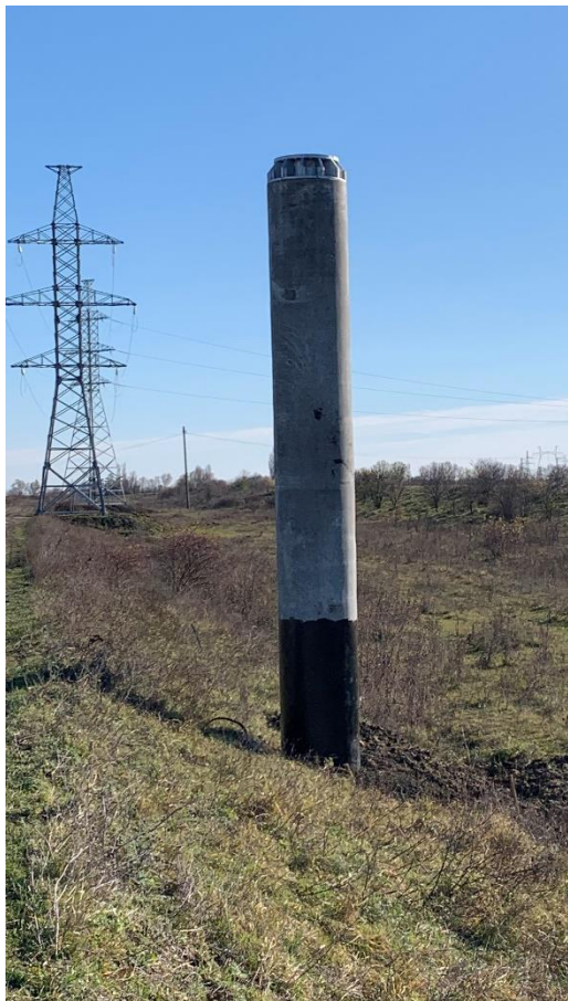
Нижняя (фундаментная) секция, установленная до монтажа конической части опоры
