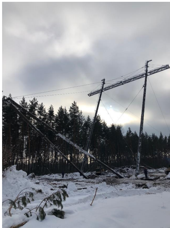
Подъём опоры методом падающей стрелы
