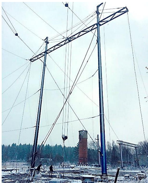
Испытания опоры на полигоне ОРГРЭС, май 2015
