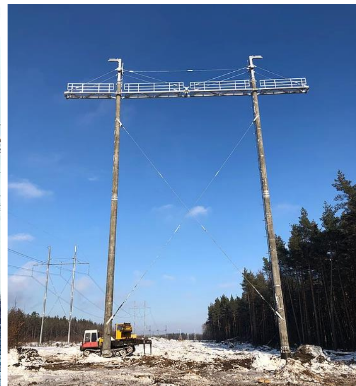
Опора на линии, январь 2019
