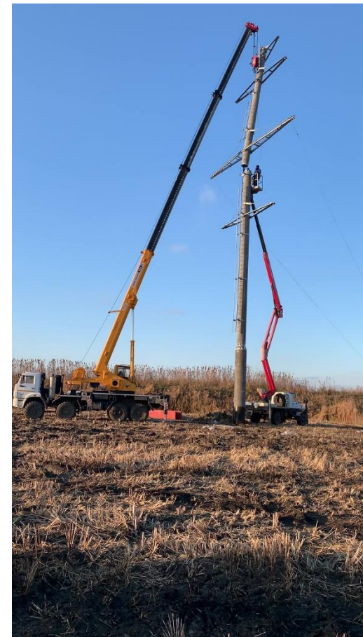
Монтаж верхней секции опоры
