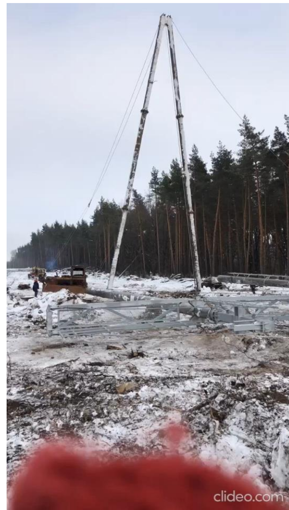
Подъём опоры методом падающей стрелы
