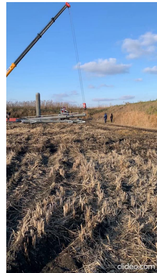
Монтаж опоры СПБ220-4ФТ, декабрь 2021
