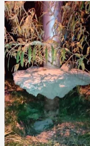
Примеры пучения опор ВЛ на грунтах Якутии
