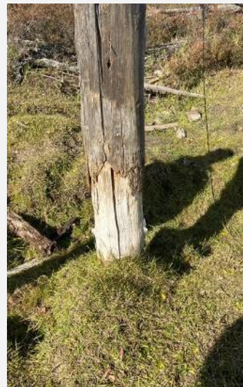
Примеры пучения опор ВЛ на грунтах Якутии
