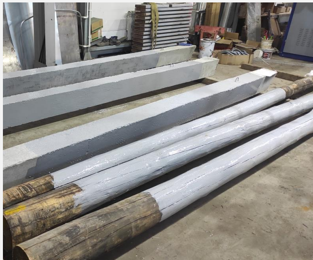
Нанесение ПСПП «Reline» и ОСПТ «Reline»
