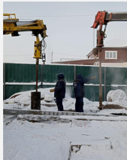
Установка экспериментальных приставок
