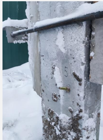
Балластировочный груз и осадочная марка на приставке
