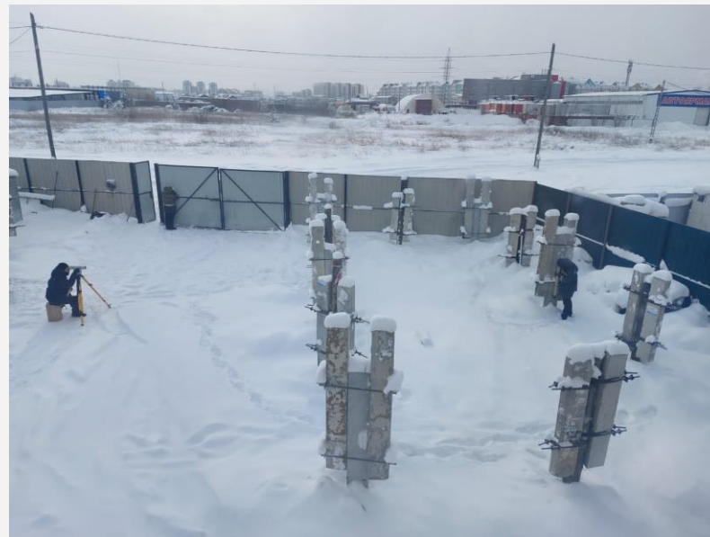
Мониторинг деформационных перемещений приставок
