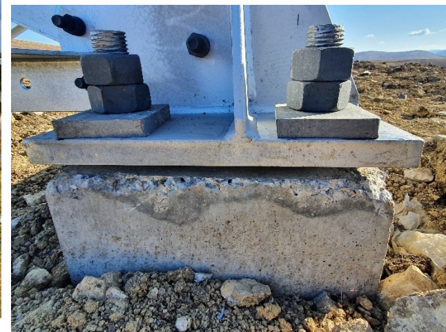
Рис. 2. Дефекты и повреждения конструкций, фундаментов и грунтового основания на стадии возведения сооружения ВЛ (неравномерные вертикальные и горизонтальные перемещения фундаментов, неплотное опирание башмаков на фундаменты, погиби элементов, незатянутые гайки, отклонение оси опоры от вертикали, дефицит оцинковки ...)
