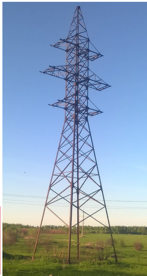
Рис. 4. Вандализм : опора ВЛ220 кВ со снятыми раскосами по высоте двух панелей пояса (Владимирская область, 2018, фото автора)
