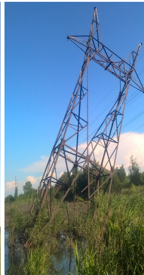
Рис. 4. Вандализм : опора ВЛ220 кВ со снятыми раскосами по высоте двух панелей пояса (Владимирская область, 2018, фото автора)
