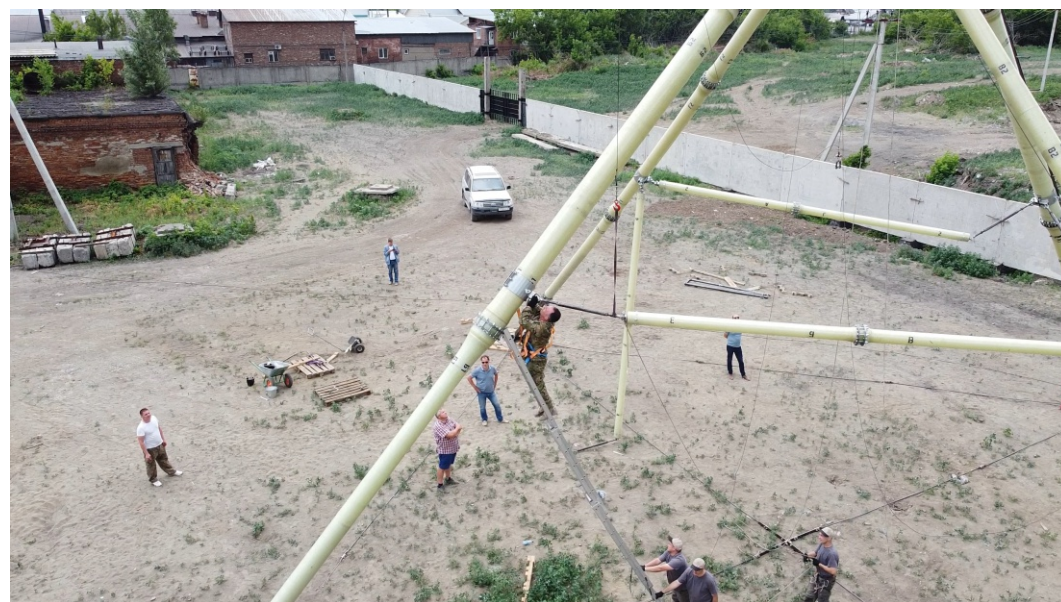
15 - ведущий подкос, 18 - лебедка, 19 - тяговый канат, 40 - жесткая связь, 42 - вершинный обводной блок, 65 - закрепление к первой точке, 66 - подъем ко второй точки закрепления
