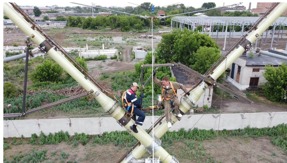
Крепление центральной площадки
