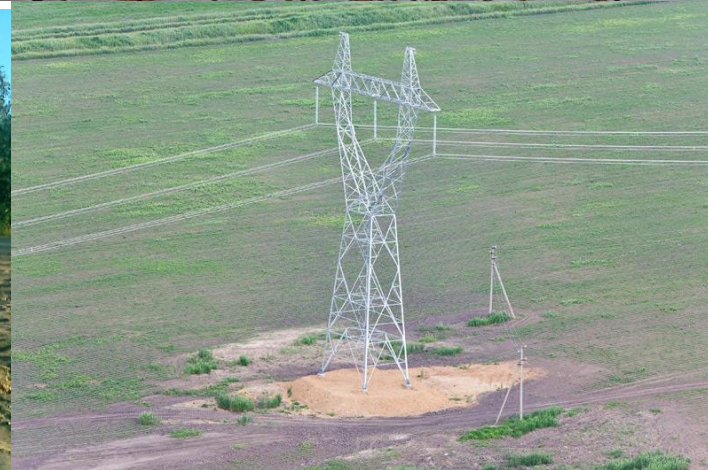
Разрушение фундаментов опор ВЛ
