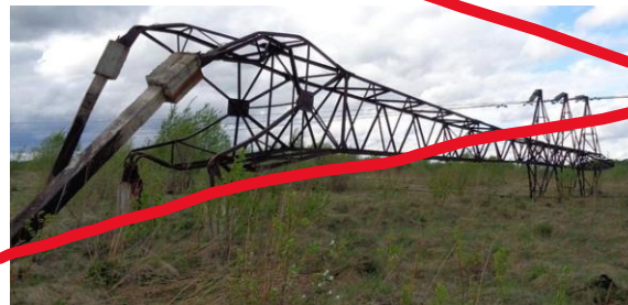
Разрушение фундаментов опор ВЛ
