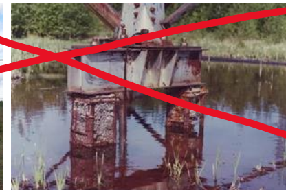
Разрушение фундаментов опор ВЛ
