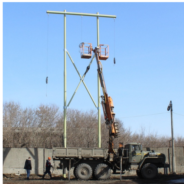
Монтаж с использованием одной машины МКМ-200
