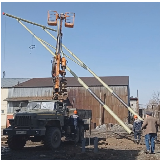
Монтаж с использованием одной машины МКМ-200
