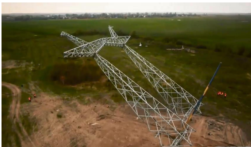
Строительная площадка для восстановления металлической опоры
