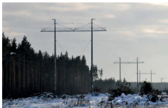
Железобетонная опора 2СПБ500-3В
