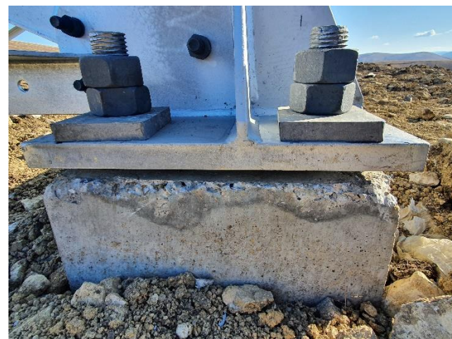
Рис. 2. Дефекты и повреждения конструкций, фундаментов и грунтового основания на стадии возведения сооружения ВЛ (неравномерные вертикальные и горизонтальные перемещения фундаментов, неплотное опирание башмаков на фундаменты, гибели элементов, незатянутые гайки, отклонение оси опоры от вертикали, дефицит оцинковки ...)
