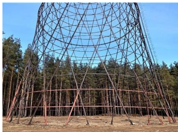
Рис. 1. Уникальная гиперboloидная опора перехода ВЛ 110 кВ через р. Ока высотой 128 м, возведенная в 1927–29 годах на левом берегу в 12 км от г. Дзержинск Нижегородской обл. (фото автора, 2014)
