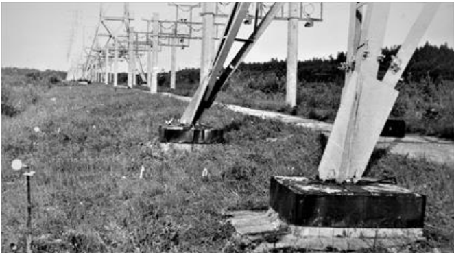
Рис. 3. Антенная группа «Заря» с линейной системой из 26 широкобазых радиобашен
