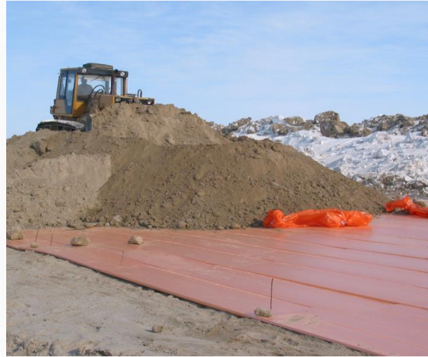
Отсыпка балласта поверх XPS в районах ММГ
