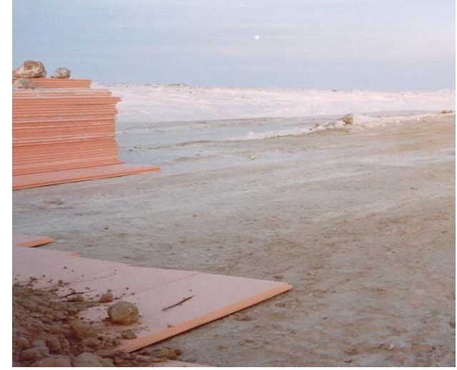
Монтаж плит XPS в районах ММГ
