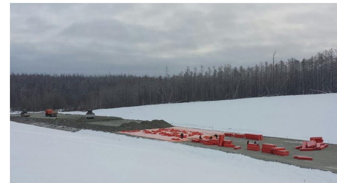
Процесс работы на захватке а/д на ММГ
