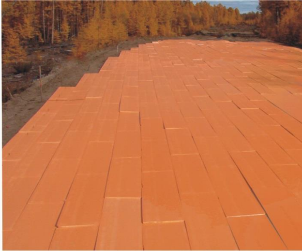
Укладка плит XPS вразбежку стыков
