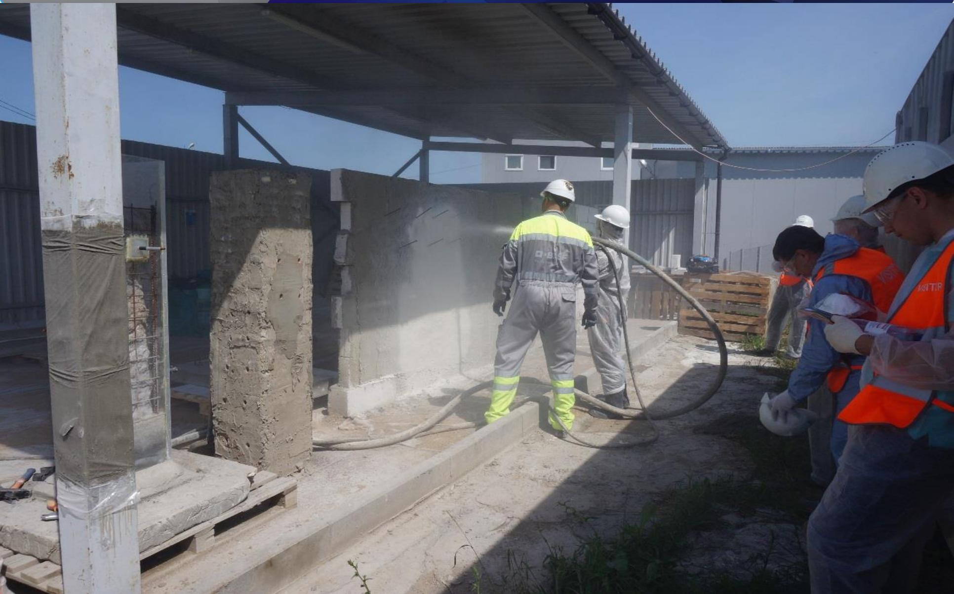
Нанесение напыляемой гидроизоляции на бетонное основание с выпусками арматуры
