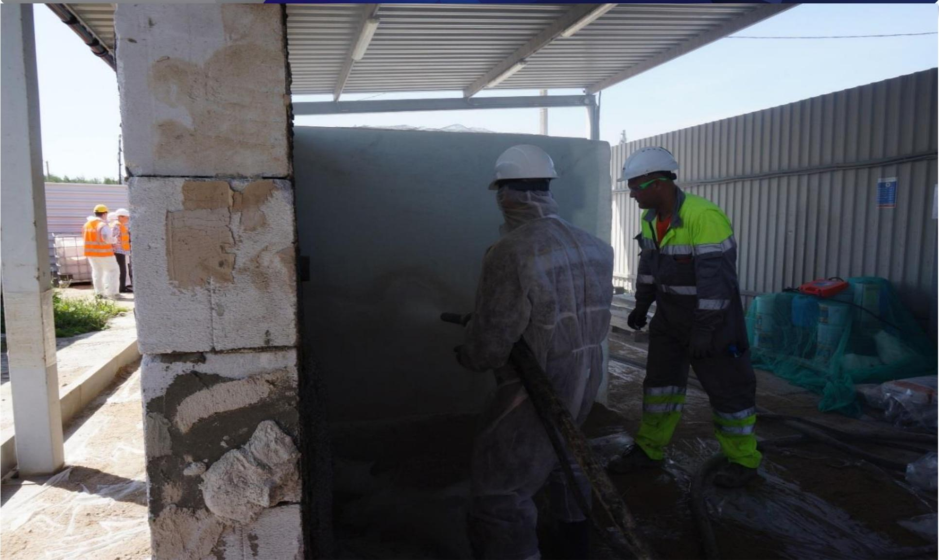
Нанесение напыляемой гидроизоляции на геосинтетическое полотно «свободно»
