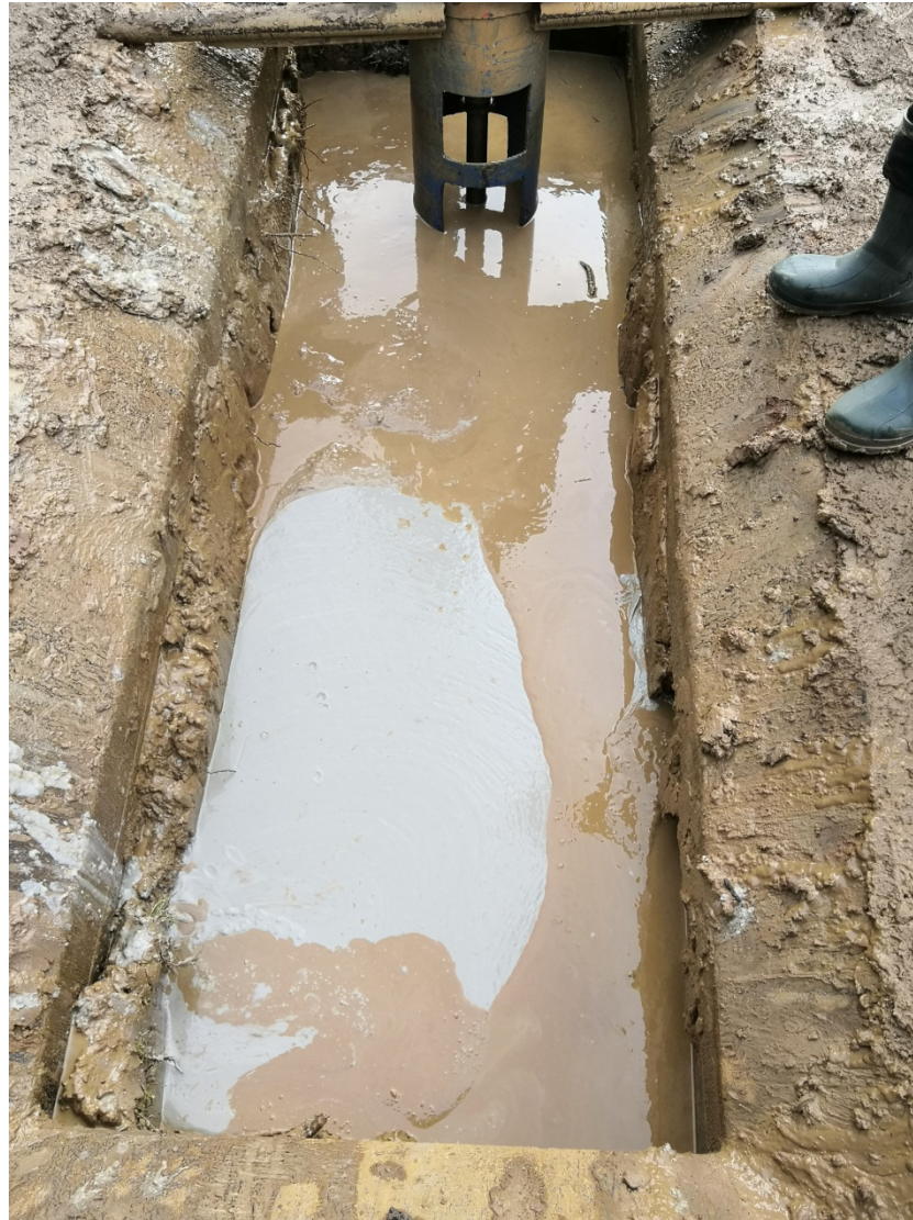
Общий вид траншеи при заполнении составом «БентИнжект»
