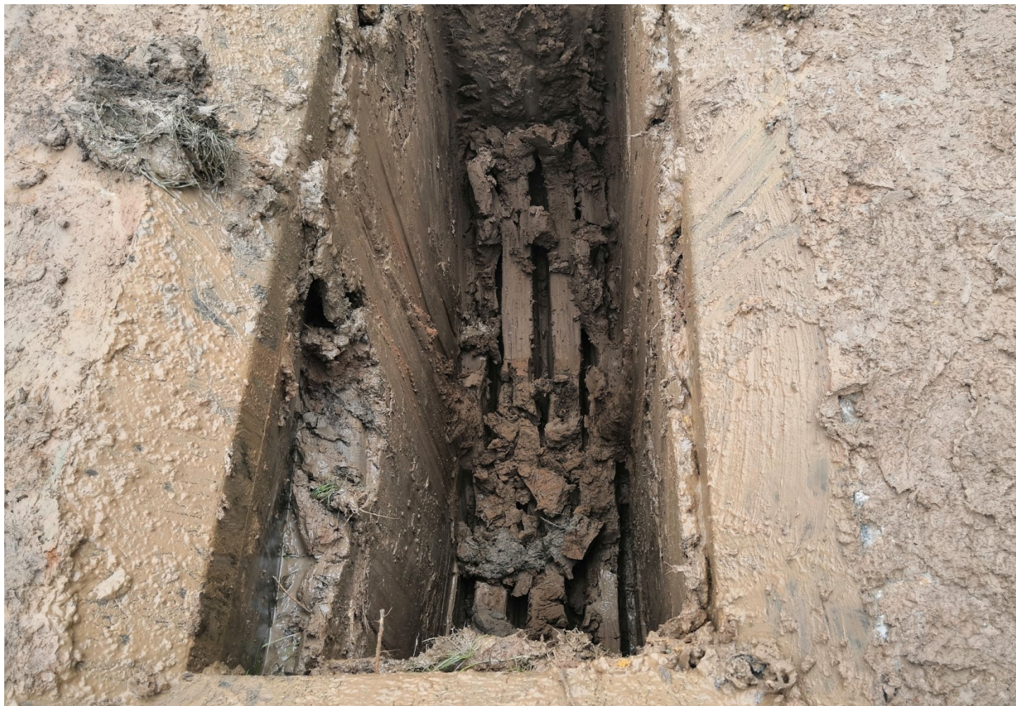
Общий вид траншеи под элемент барьера по технологии «стена в грунте»
