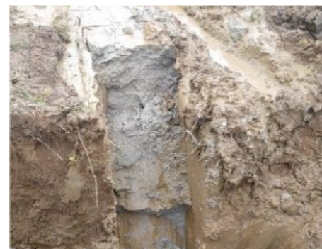
Фото устройства «стены в грунте». ОНР 2019 год
