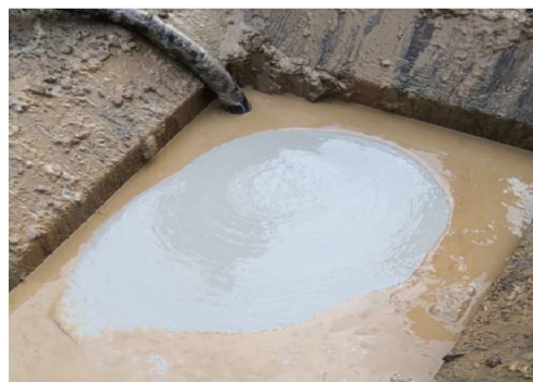
Фото устройства «стены в грунте». ОНР 2019 год
