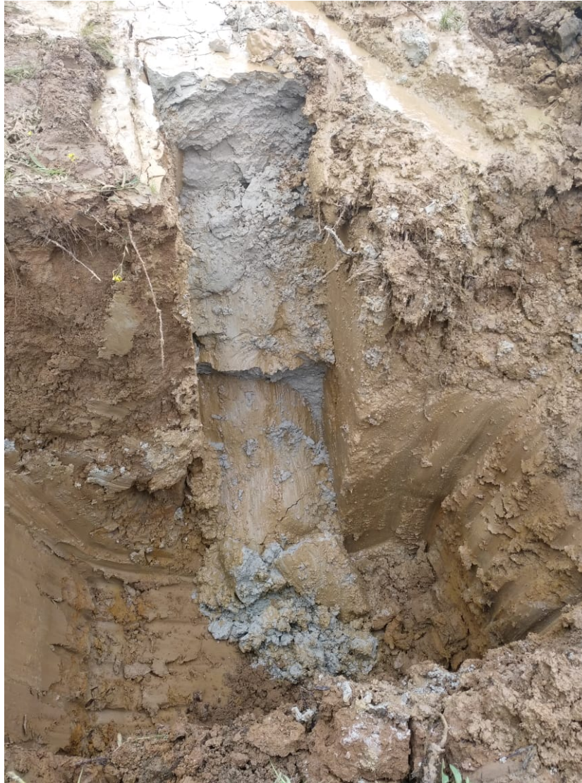
Общий вид элемента защиты из состава «БентИнжект»
