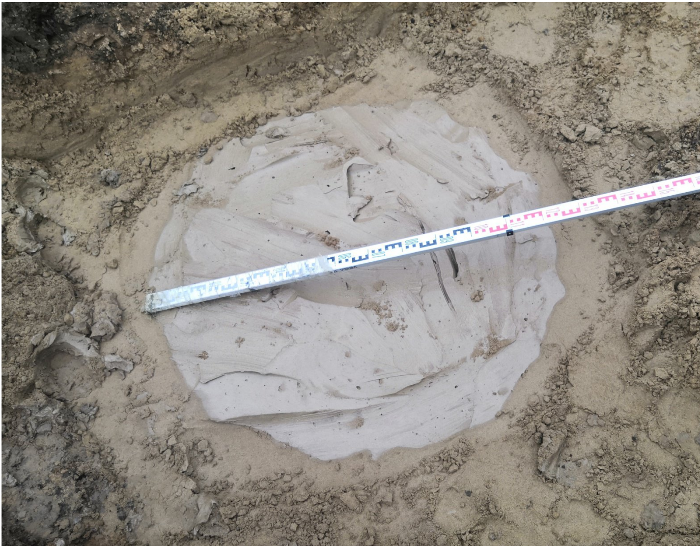
Общий вид ствола элемента замесы по технологии jet-grouting
