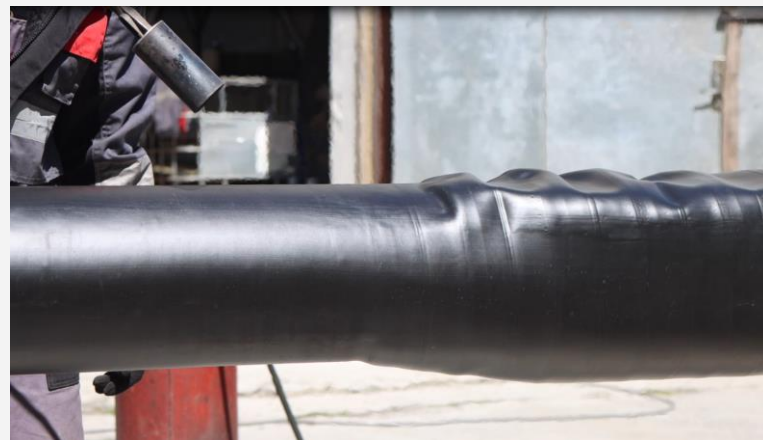
Монтаж противопучинной оболочки ОСПТ «Reline» в трассовых условиях
