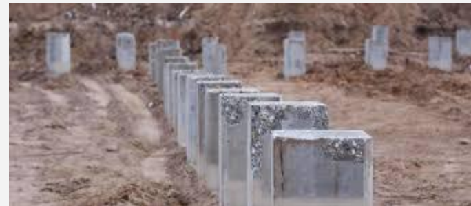
Сваи ж/б с противопучинным покрытием ПСПП «Reline»
