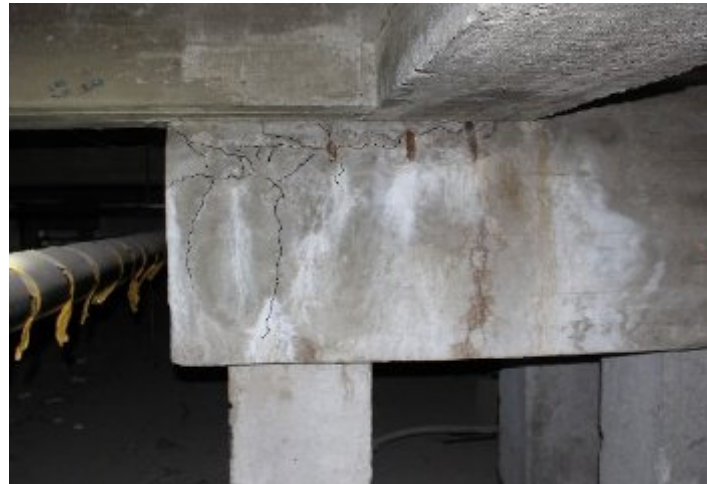
Оттаивание массива ММГ (актуально для районов распространения ММГ)
