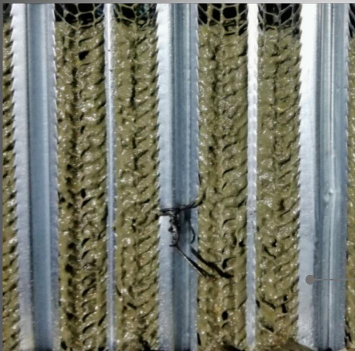
За счет адгезии проступившего цементного молочка и металла ячеек, опалубка включается в работу конструкции
